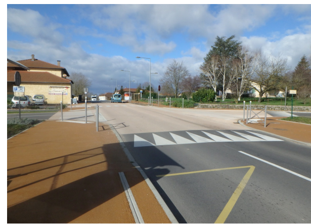
Illustration 8. Aménagement du carrefour situé à proximité de l'arrêt
