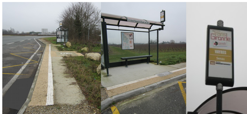
Illustration 7. de gauche à droite. Quai de l'arrêt ; abribus avec panneau d'affichage et banc ; totem fixé à l'abri
