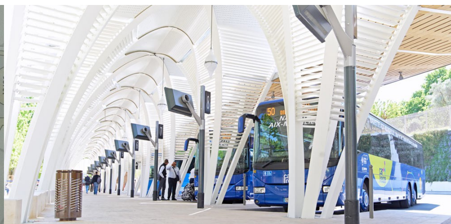
Illustration 4. Photo de la gare routière
