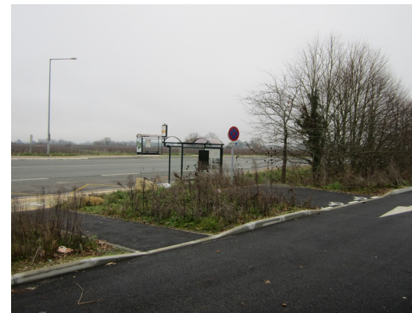
Illustration 3. Place réservée PMR dans le parc relais
