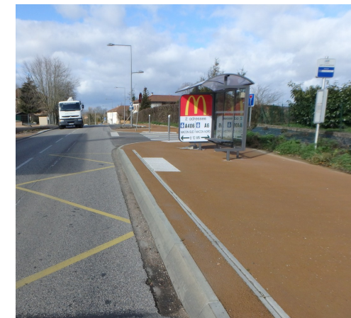
Illustration 5. Photo de la bordure de trottoir biaise
