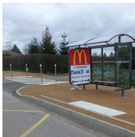
Illustration 7. Abribus et passage piéton accessible
