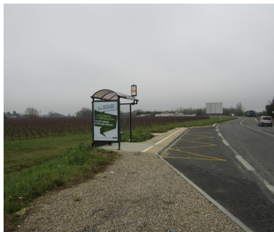
Illustration 2. Arrêt en encoche
