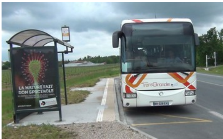
Illustration 6. Bande de guidage de couleur blanche et zone de sécurité en revêtement contrasté
