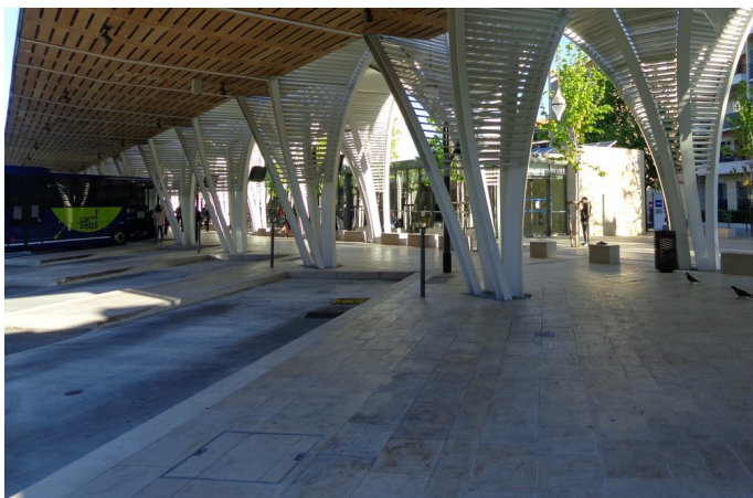
Illustration 5. Quais aménagés en épi
