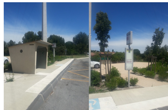
Illustration 6. Aménagements du quai. A gauche, bordure surélevée. A droite, accès au parking.
