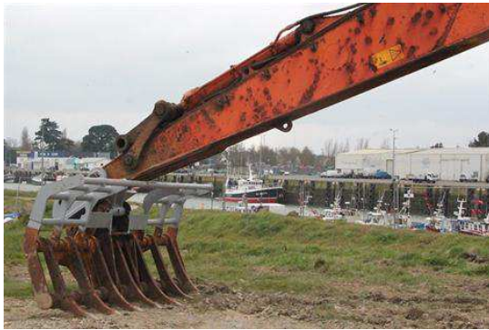
Pelle sur ponton avec godet à peigne
