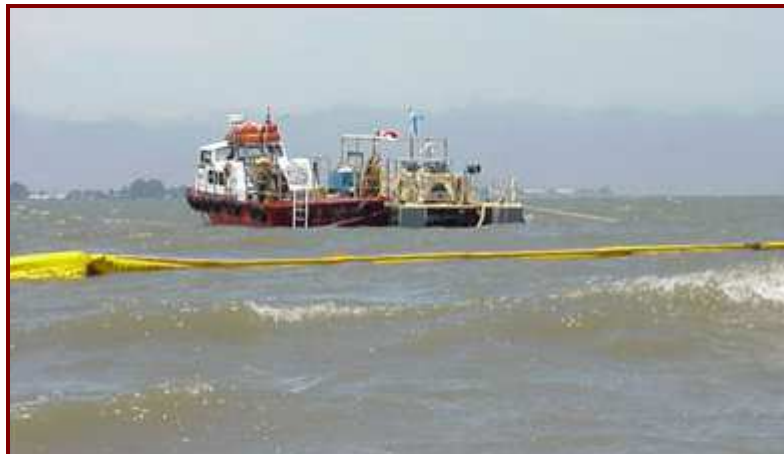
Figure 15 : écran anti-turbidité déployé dans la baie de San Francisco
