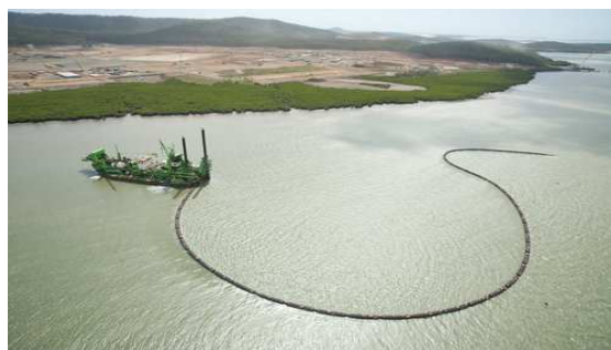
Figure 12 : Dragage et immersion par refoulement en conduite
