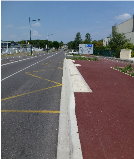
Arrêt accessible "classique" implanté par la CAPI : 10 700 € HT en moyenne
