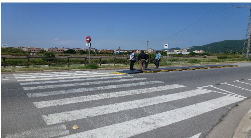
Implantation d'un passage piétons pour accéder au quai, rampe pour l'accès au quai que d'un seul côté
