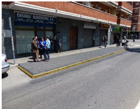
Aménagement du quai de bus modulaire
