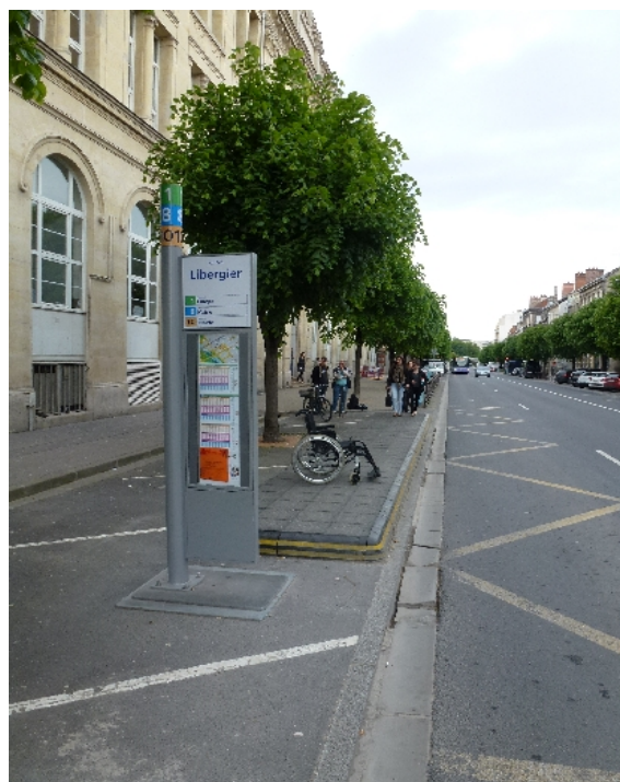
Aménagement d'un quai de bus modulaire
