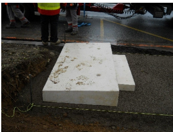
Mise en place de la rampe d'accès
