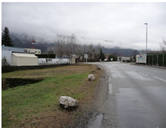
Arrêt de bus "Les Peupliers" (commune de Domène) Avant aménagement
