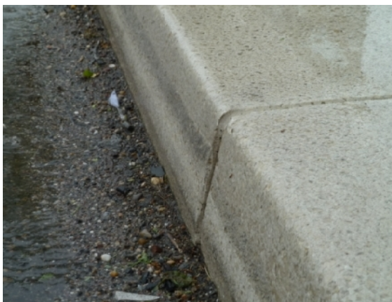
Vue sur l'alignement en bordure (entre le quai et la rampe)
