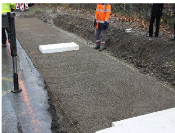
Mise en place de la clé de blocage
