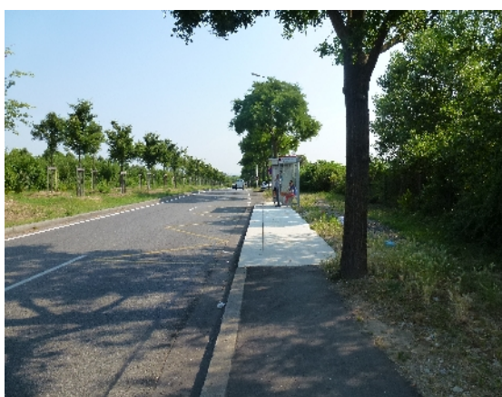
Alignement avec le trottoir existant satisfaisant
