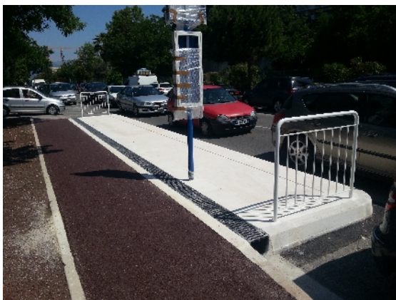
Quai aménagé en avancée, dans l'alignement du stationnement longitudinal. C'est un aménagement non terminé à ce jour (il manque encore la partie information à l'utilisateur et l'abri-bus).
