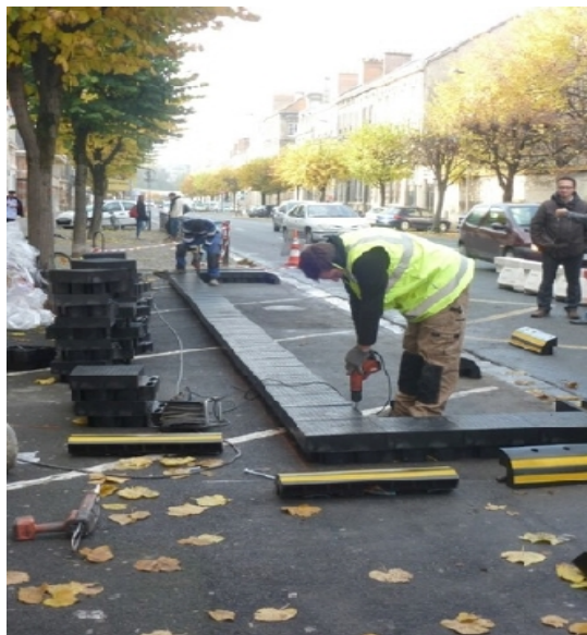
Montage du quai
