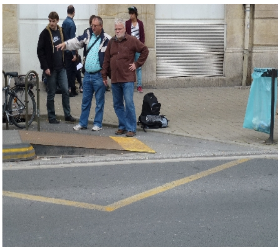
Le quai est aux normes accessibilité, par contre la continuité avec le trottoir n'est pas assurée
