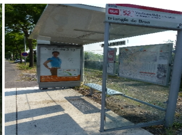
Réservation pour l'abri réalisée après la pose du quai
