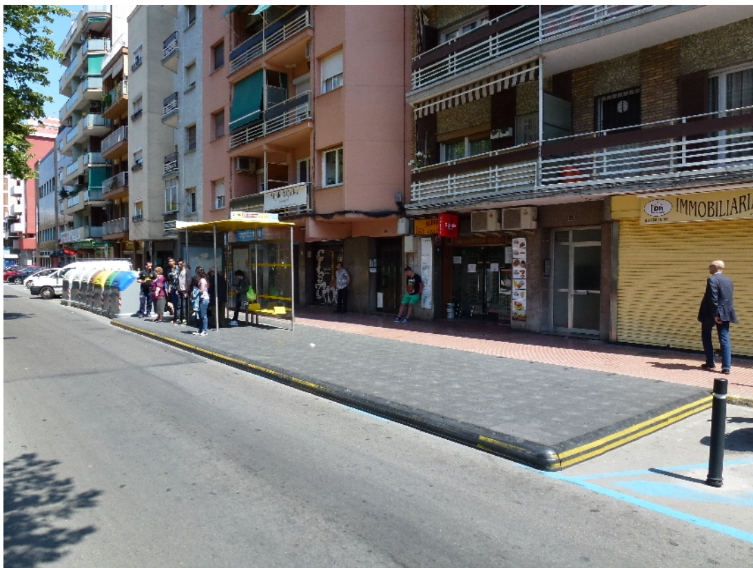
Quai bus modulaire avec un abri bus
