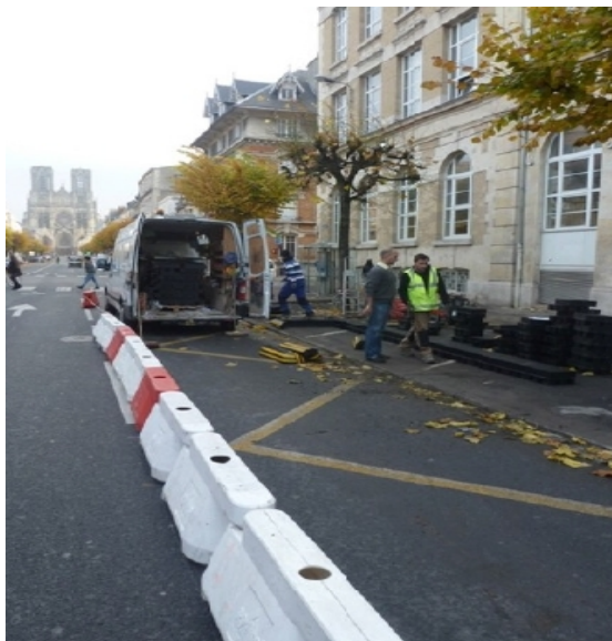
Montage du quai
