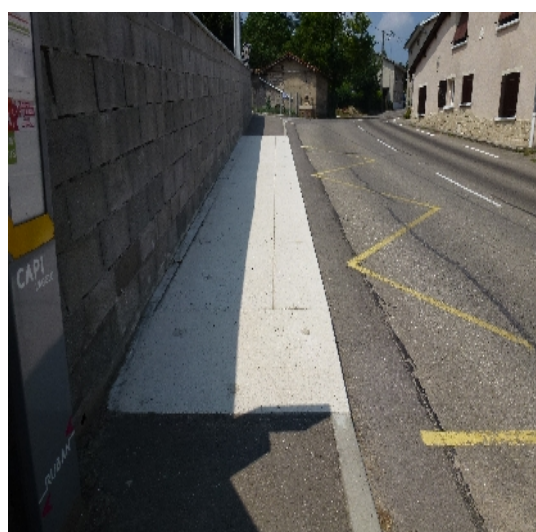
Sciage de la chaussée bien au-delà du quai
