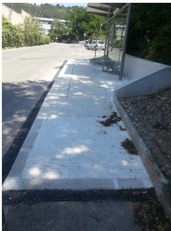
Quai aménagé en avancée, dans un contexte péri-urbain et donc sans aucune continuité de cheminement piéton. L'arrêt a été créé à la demande de parents d'élèves. L'aménagement d'un cheminement piéton coûterait relativement cher (nécessité de créer un mur de soutènement comme cela a été fait pour l'arrêt). L'arrêt pourrait avoir une durée de vie limitée et pourrait donc être démonté à plus ou moins court terme.
