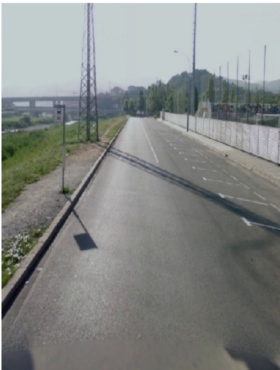
Avant aménagement du quai de bus modulaire
