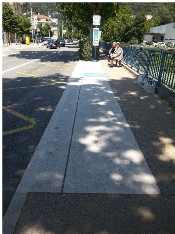
Quai aménagé en ligne, avec intégration et reprise du trottoir existant, sans toucher la chaussée existante.
