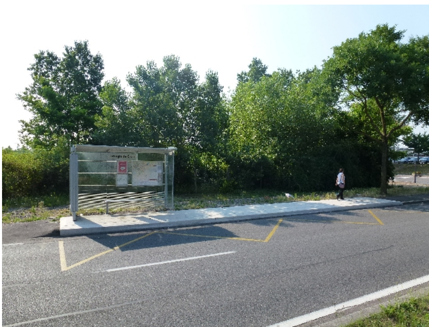
Quai en alignement, en milieu péri-urbain sur le territoire communal de Bron. Le quai mesure 12 m de longueur, 2 m de largeur avec 1 rampe. Sciage de la chaussée bien au-delà du quai, sur une chaussée qui semblait neuve ou très récente : ce choix oblige à une reprise chaussée importante qui pourrait altérer la résistance à l'orniérage. Alignement longitudinal des bordures : on observe un léger décalage pouvant altérer les pneus.
