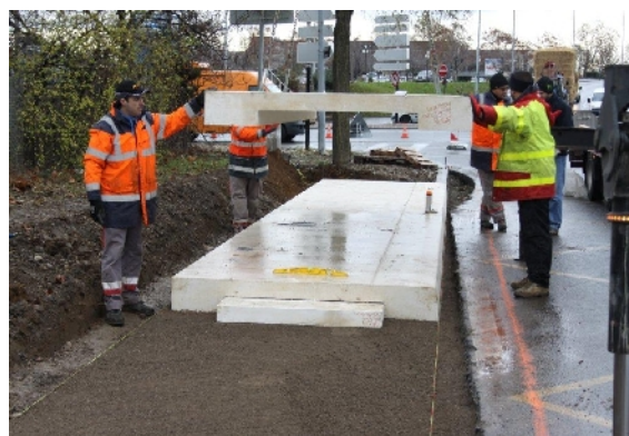
Mise en place du 2e élément de 6m
