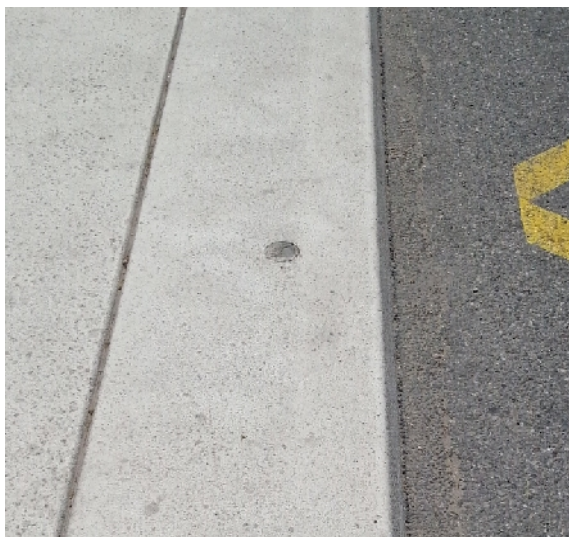
Détail au niveau du raccordement avec la chaussée existante (simple sciage) et rebouchage de la réservation prévue pour le passage des élingues nécessaires lors du montage du quai
