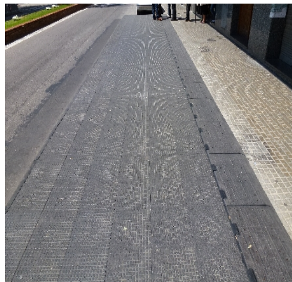
Continuité avec le trottoir grâce à la grille d'accès
