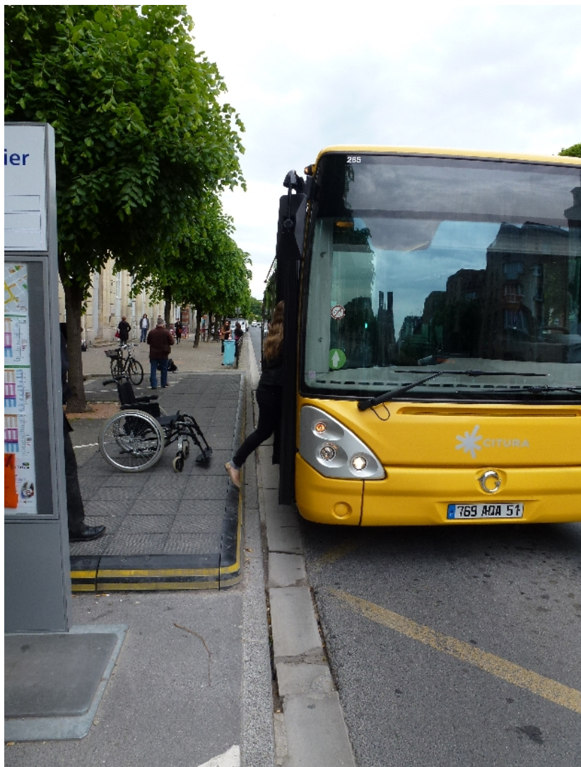
Il n'y a pas eu de reprise de la chaussée, l'accostage du bus ne peut se faire au plus près du quai. Les informations sur le totem ne peuvent être visibles depuis la plate-forme.
