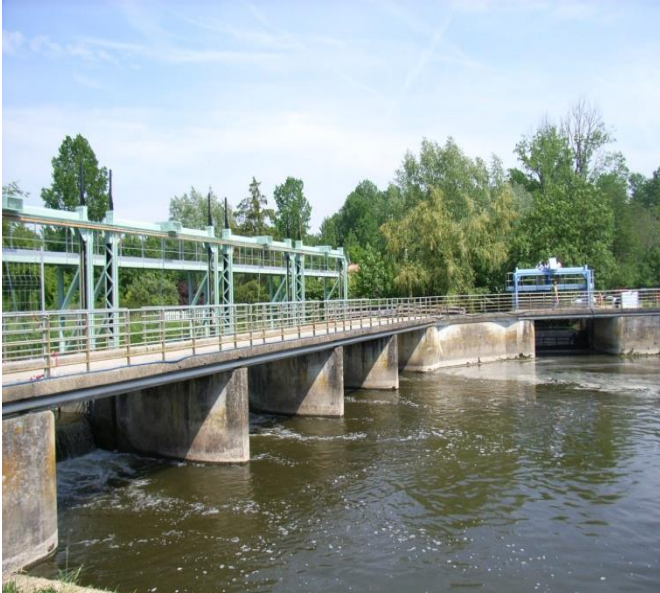
Plusieurs barrages pour un même « bief » ou « étage hydraulique »
