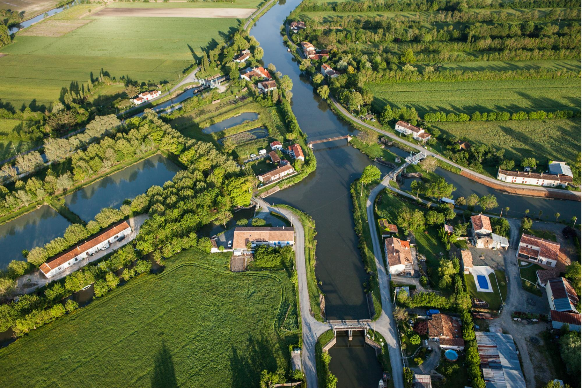
Confluence des bassins de la Sèvre, du mignon et de l'Autize – lieu-dit « Bazoin » altitude moyenne des terrains : 2,10 m NGF Niveaux d'eau normaux : 1,85 m NGF
