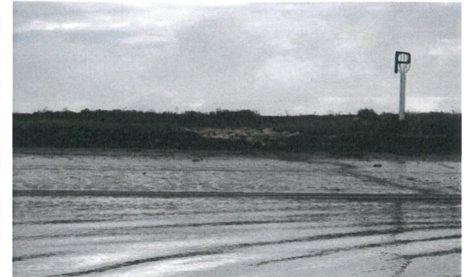
4 : Exutoire et fin de la zone de renforcement par enrochement
