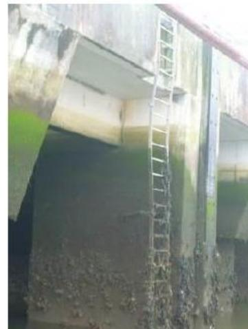
Figure 21 : Déformation des échelles d'accostage due aux chocs et non-conformité de celle-ci (absence de crinoline)
