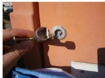
Figure 23 : Equipement de secours non accessible (clef non adaptée au matériel)
