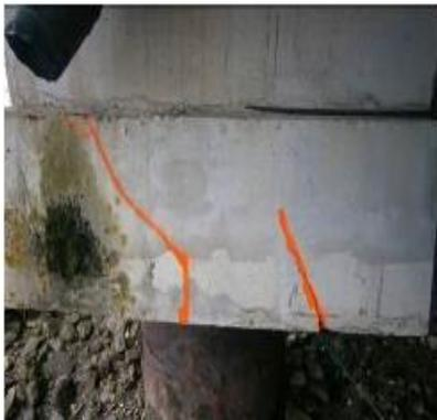
Figure 17 : Plate-forme hall Preg, apparition de fissures inclinées à 45°, conséquence d'une insuffisance de la résistance aux efforts tranchants ou encore une perte de section et d'adhérence des armatures due à la corrosion
