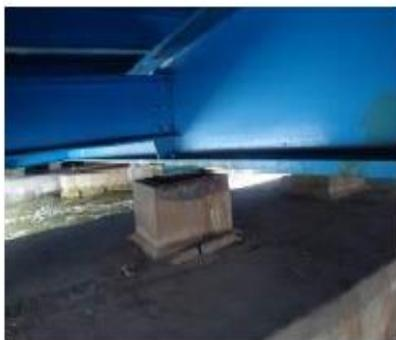
Figure 15 : Pont Gueydon, foisonnement de la plaque d'appui entraînant l'éclat du béton, conséquence d'une corrosion due à la pénétration d'agents agressifs tel que chlorure et dioxyde de carbone.
