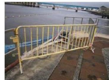
Figure 22 : Absence de garde-corps anti chute.
