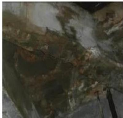
Figure 16 : Station de pompage de la forme de construction, foisonnement des armatures oxydées entraînant l'éclat du béton et l'apparition des armatures, conséquences d'une corrosion des armatures due à la pénétration d'agents agressifs tel que chlorure et dioxyde de carbone.
