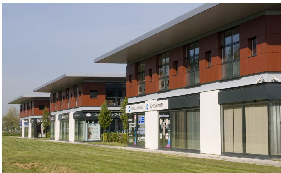
Source : DRIEA/Gobry (2011) – Zone industrielle à Serris
