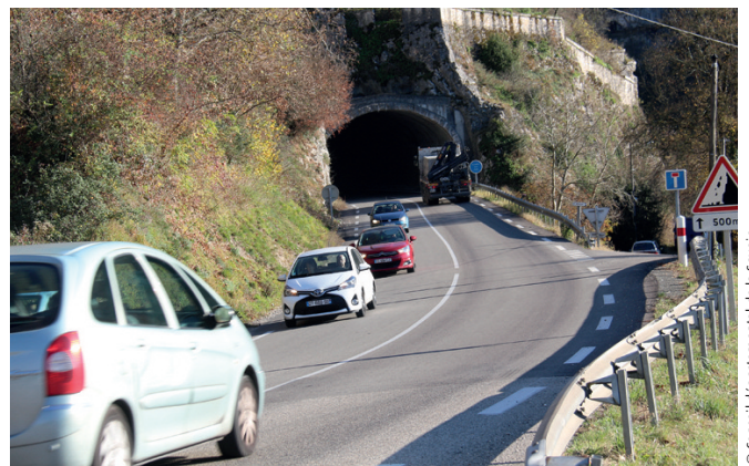
Tunnel de Virignin
