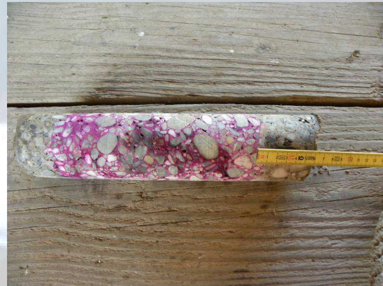
Essai de carbonatation
