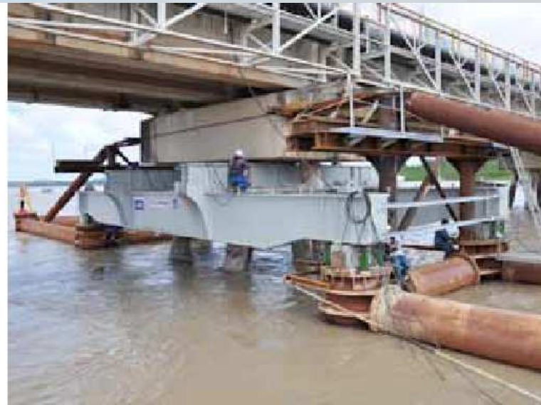
Confortement d'une pile menacée
