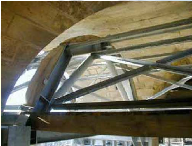
Étaitement provisoire pour éviter l'effondrement
