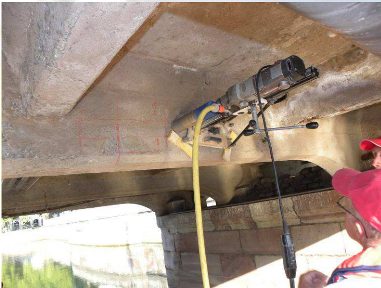
Carottage d'une poutre armée
