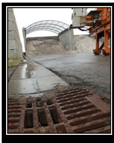
Stockage des fondants routiers à Escoeuilles
