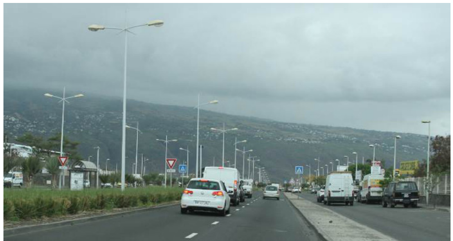
N7 - Ville du Port - Voies équipées en éclairage exclusif SHP
