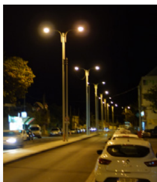
Saint Pierre - Boulevard Hubert Delisle Éclairage SHP
