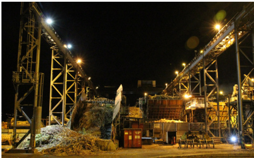
Usine de Bois-Rouge (campagne sucrière septembre 2016)
