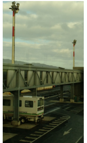
Aéroport : éclairage de grande hauteur des aires de stationnement des avions en SHP
