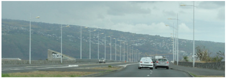
Le Port : Installations hors agglomérations a priori déjà éteintes en raison d'usages nocturnes exclusivement routiers
