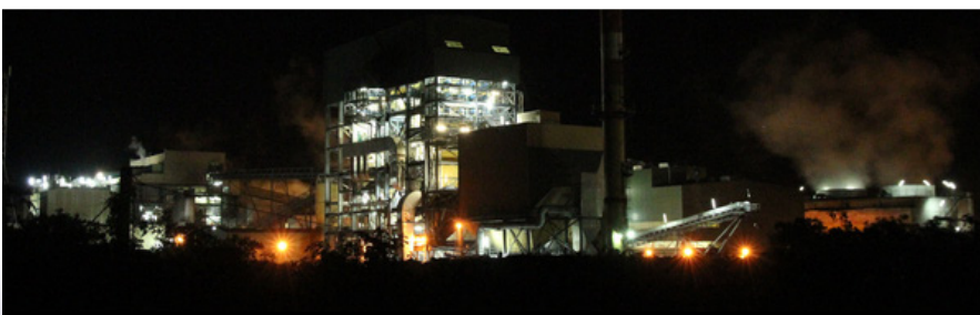
Usine de Bois-Rouge (campagne sucrière septembre 2016)
