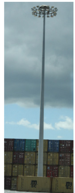
Installations plus récentes suite à la rénovation des quais (les projecteurs asymétriques sont réglés à 0°)
