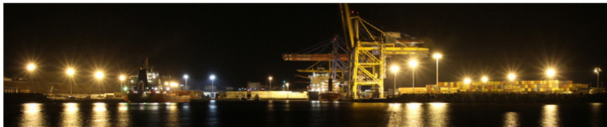
Éclairage nocturne des installations portuaires - Fortes puissances et fortes déperditions de flux lumineux Fonctionnement 100 % en période d'inactivité du Port
