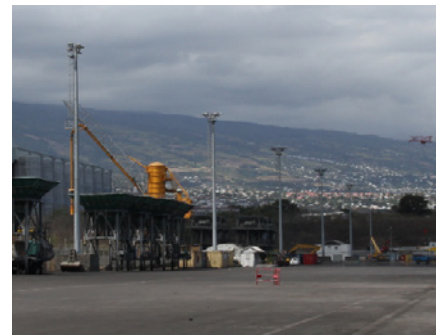
Installations plus récentes suite à la rénovation des quais (les projecteurs asymétriques sont réglés à 0°)
