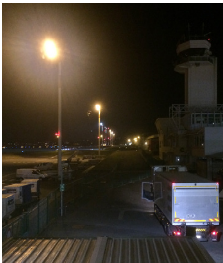
Eclairage de l'aéroport Roland Garros: présence de grands mâts équipés en SHP – projecteurs installés avec une très forte inclinaison
