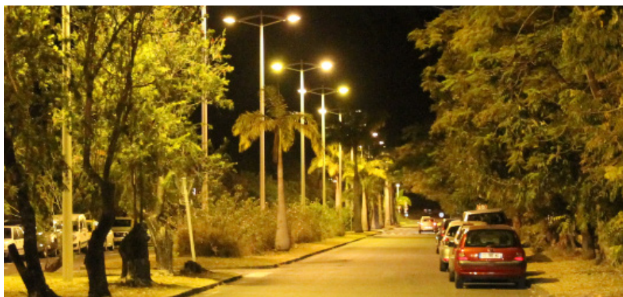
Saint-Gilles-les-Bains - Avenue de la mer – Voirie équipée en éclairage exclusivement SHP
