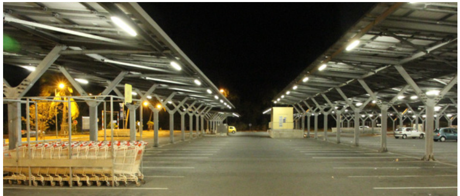
Parking sous panneaux photovoltaïques - Saint-Paul
