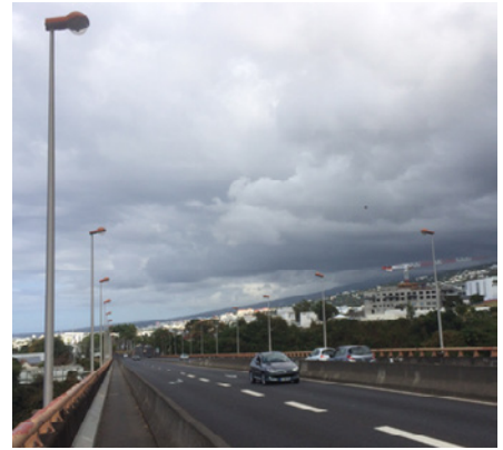
Saint-Denis : Pont Vin-Sanh - Cette installation sur la RN6 à l'entrée ouest de Saint-Denis n'est plus en milieu urbain (circulation motorisée quasi exclusive) et de plus franchit une ravine où les enjeux biodiversité peuvent s'avérer importants. La question du maintien de l'éclairage peut se poser
