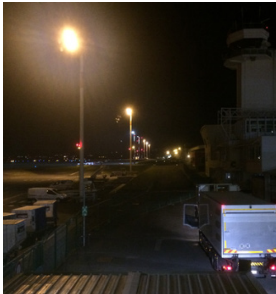
Aéroport : éclairage de grande hauteur des aires de stationnement des avions en SHP
