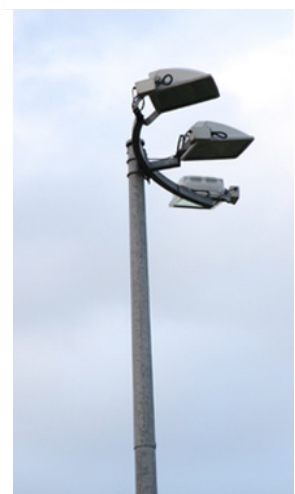
Éclairage par projecteurs asymétriques installés avec une inclinaison importante à nulle selon les sites
