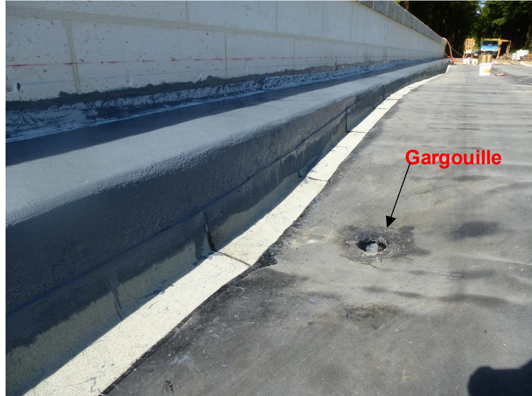
Mise en place du drain
