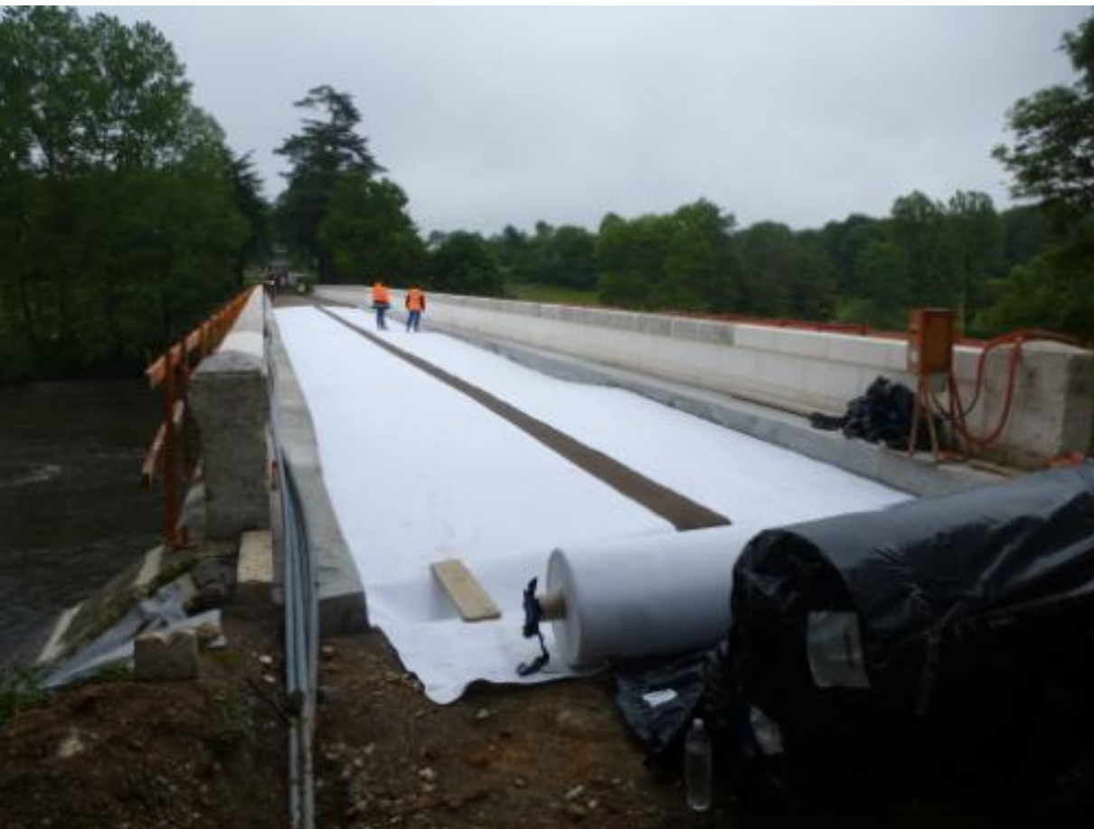
Pose géotextile 700 g
