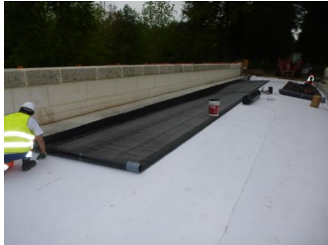
Pose géomembrane
