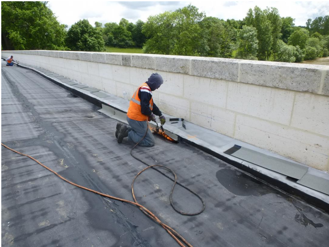
Pose relevés d'étanchéité(chape collée)
