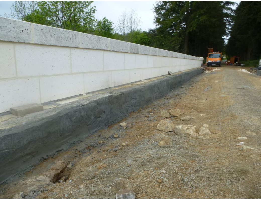
Reprise mur tympan
