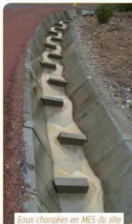
Eaux chargées en MES du site
