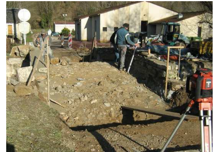
Voûte après décaissement
