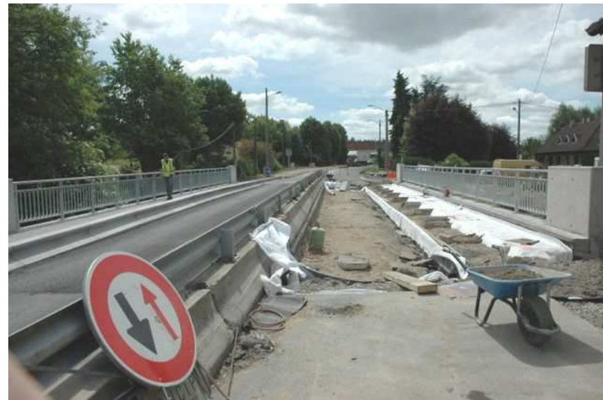
Remplissage sur Étanchéité intermédiaire
