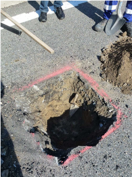
Sondage et décaissement
