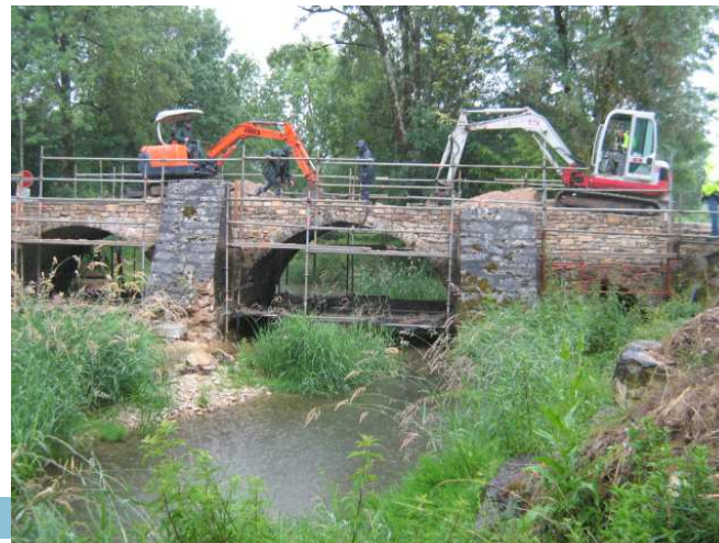
Sondage et décaissement
