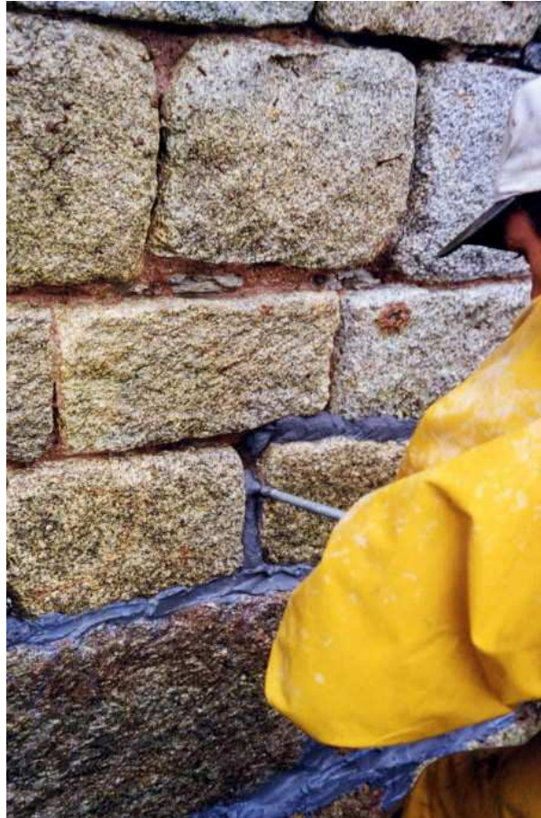
Projection par voie mouillée
