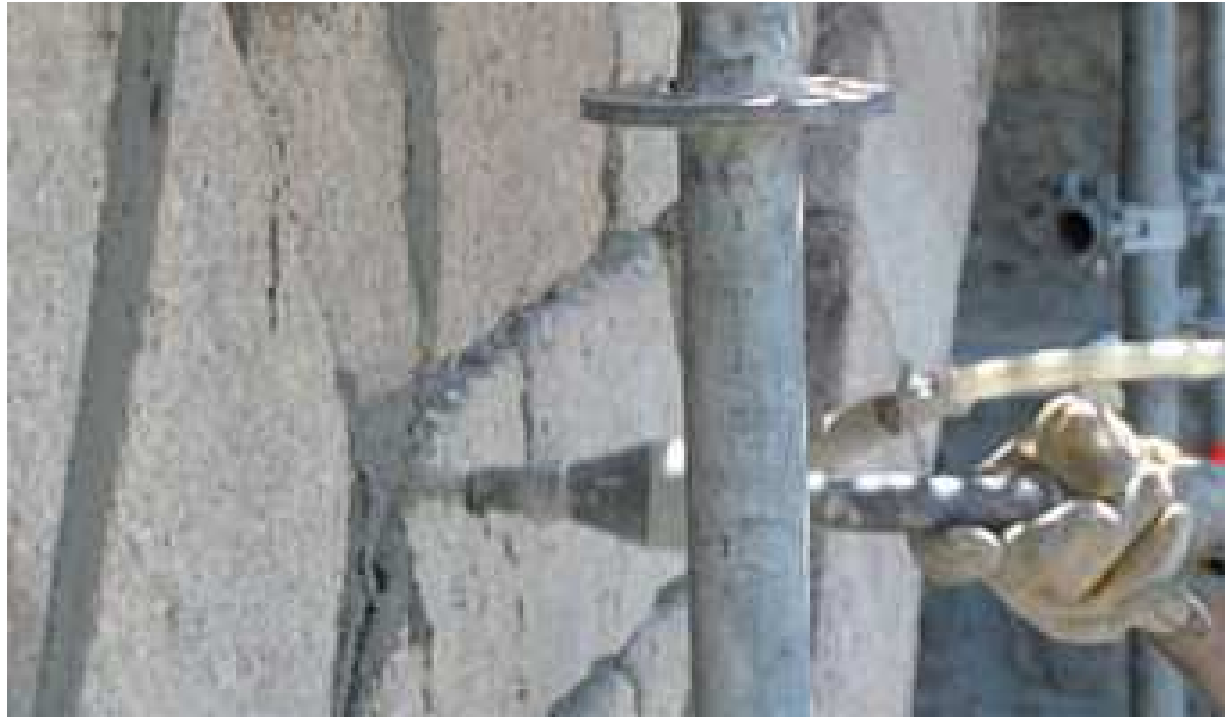
Projection par voie mouillée
