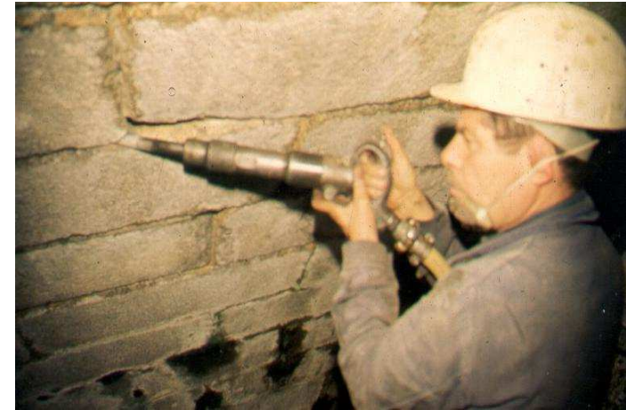
Dégarnissage mécanique
