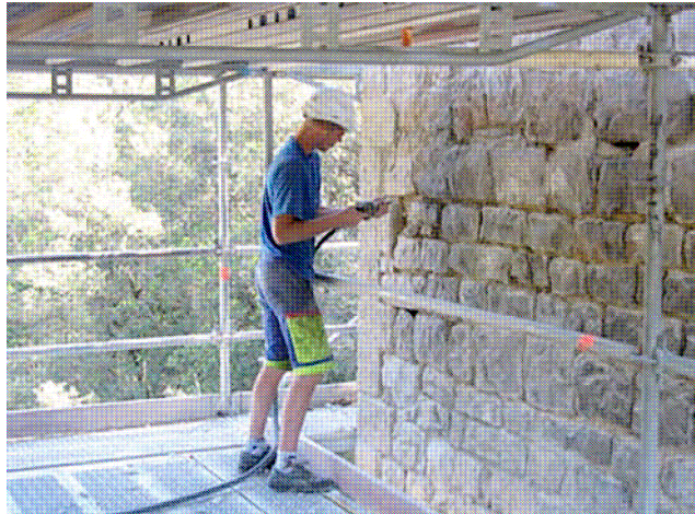
Dégarnissage mécanique
