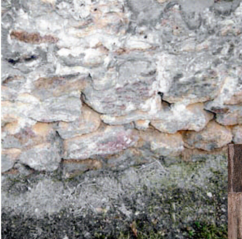
Disjoiement d'un mur
