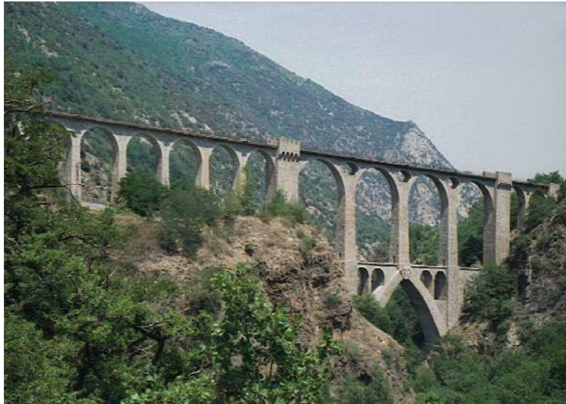
Pont de Fondpédrouse Pyrénées orientales - ( 1908 )
