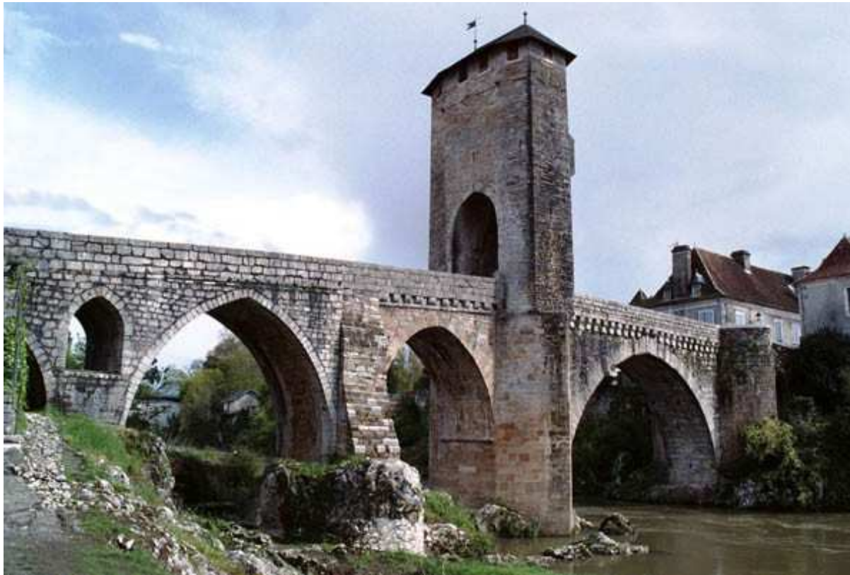
Le Pont d'Orthez sur le Gave de Pau ( XII ème siècle ) Longueur totale de 46.00 m - Ouverture de la grande travée : 14.87 m Ouvertures des deux arches adjacentes : 7.10 m et 7.65 m
