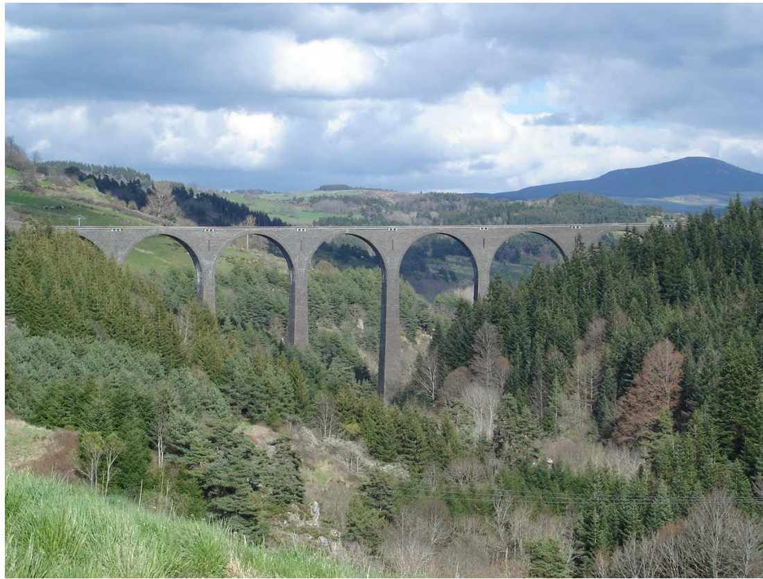
Viaduc de la Recoumène - Haute Loire ( 1925 )
