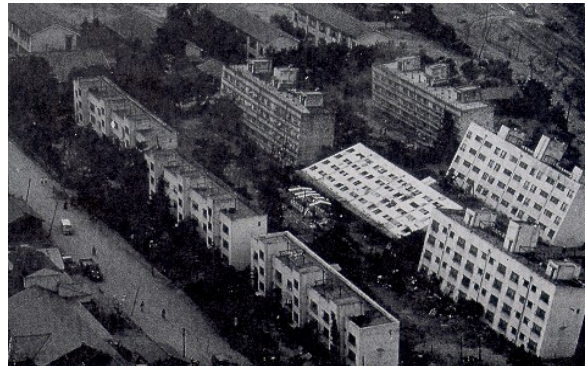
Perte de portance des fondations sous l'effet de la liquéfaction (Niigata, 1964)
