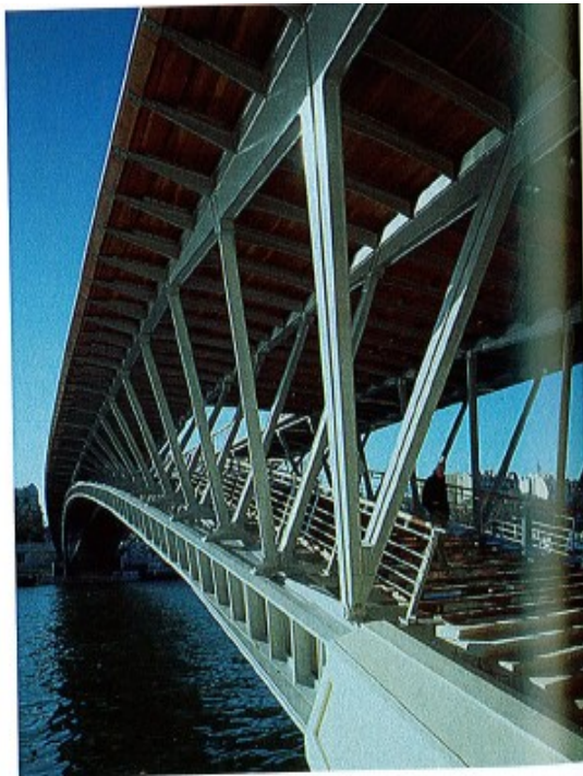
Photo A.4.6 : passerelle de Solferino – Source : architecte Marc Mimosa
