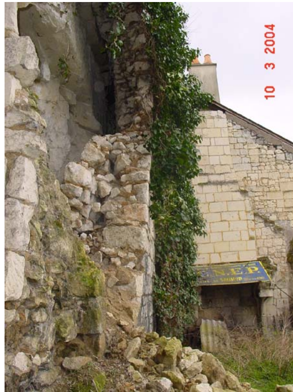
Photo 6 : Maison adossée au coteau à Dampierre-sur-Loire
