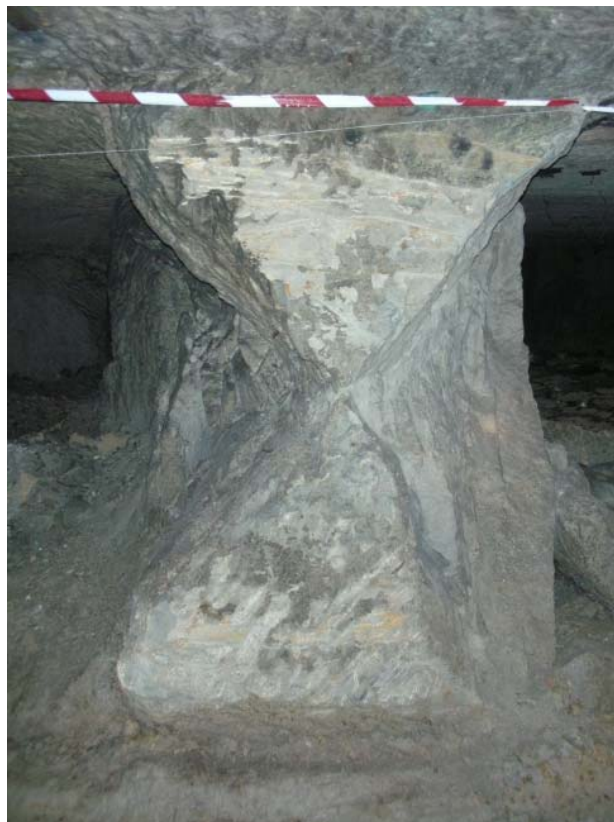
Photo 1 : Pilier d'une carrière à Saumur
