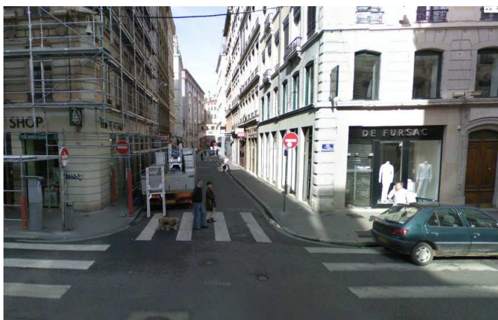
Carrefour Herriot/Thomassin (avant travaux)
