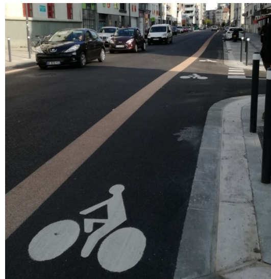
Rétrécissement de chaussée par marquage cycles
