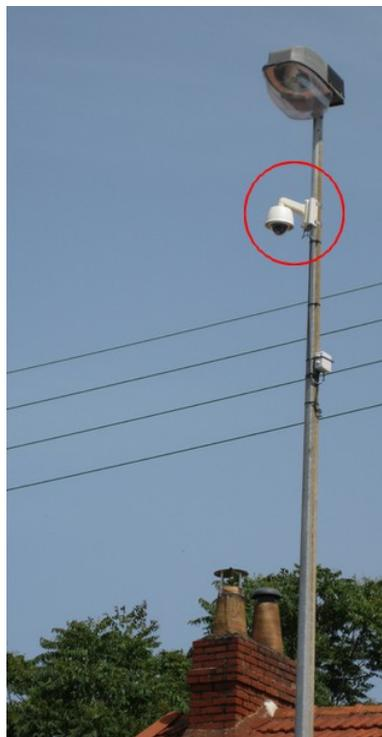
*Illustration 2: Autoscope fixé sur le mat d'éclairage*
