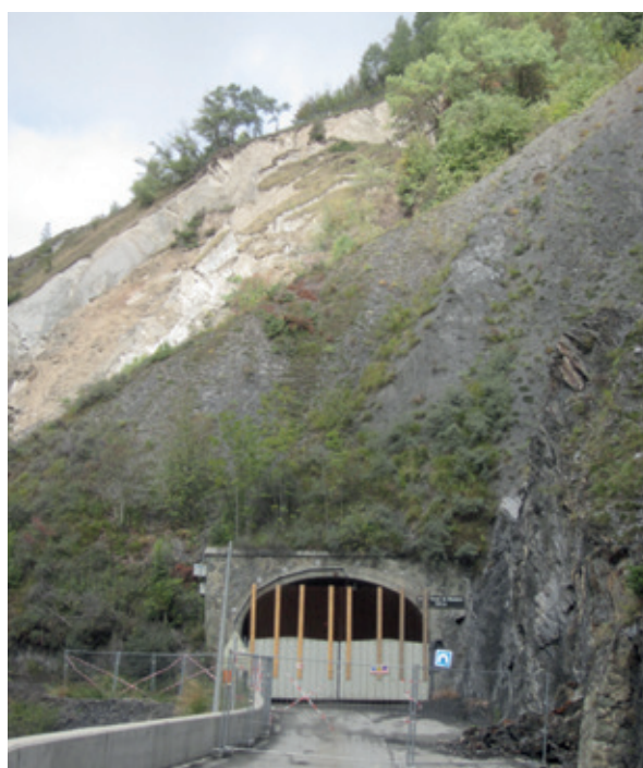
La tête du tunnel côté Hautes-Alpes avec le glissement de terrain en arrière-plan.
