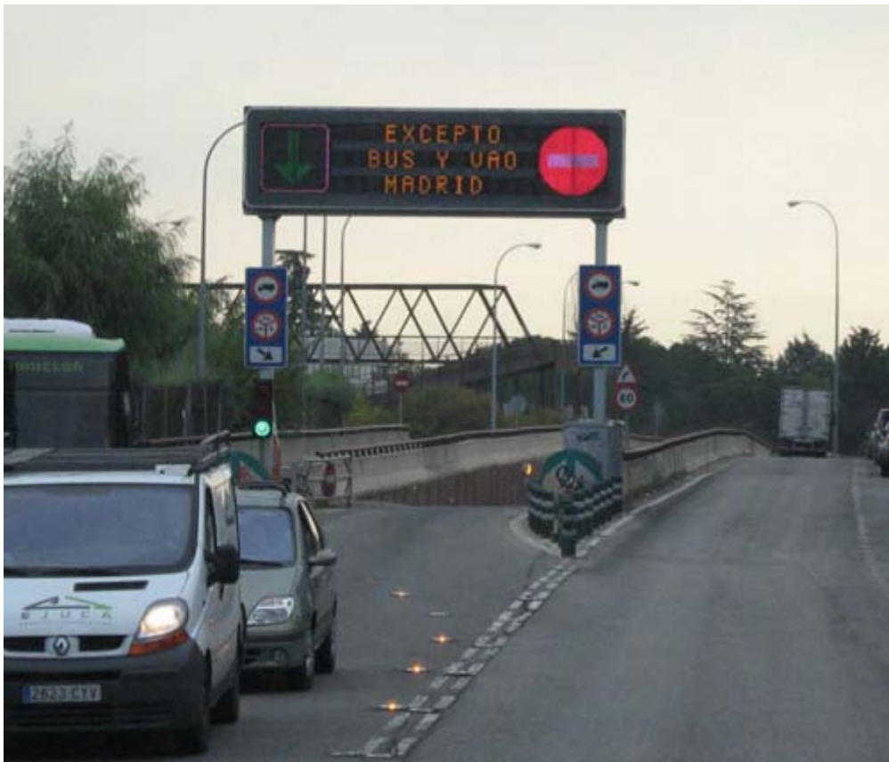
Madrid: BusVAO, entré nord de la voie dédiée réversible, au centre de l'autoroute
