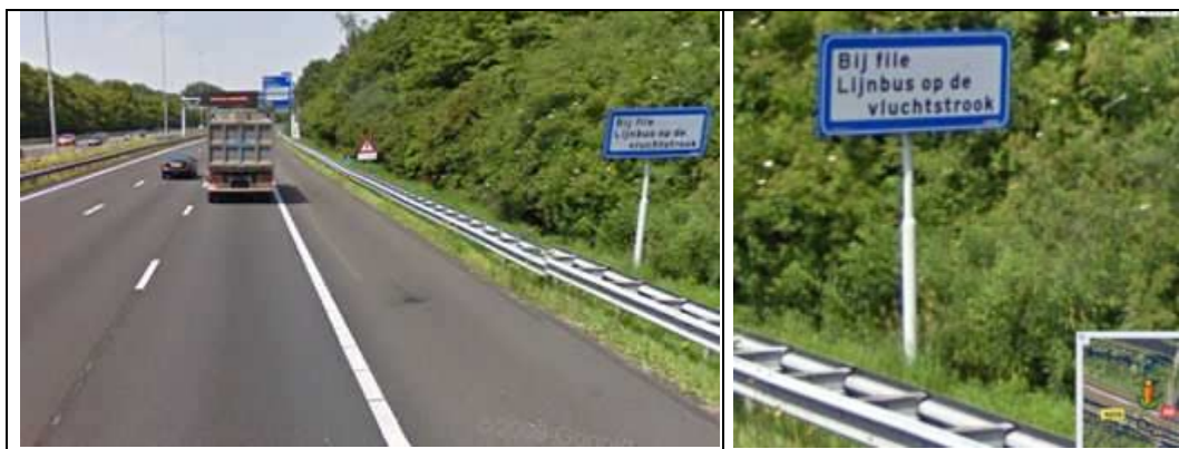
Zuidtangent sur l'autoroute A9, utilisée en cas de congestion, comme indiqué sur le panneau, "En cas de congestion ligne de bus sur la bande d'arrêt d'urgence"
