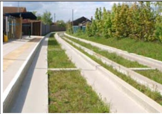
Cambridge: la voie de guidage est en béton, elle permet de réduire une maintenance qui serait peu pratique sur les 40 km – on observe aussi l'absence d'un réseau pluvial
