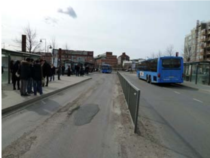
A Gothenburg, la ligne 16 a la plus forte capacité. Les bus bi-articulés ont leur propre quai, Le premier sur la gauche. Le second quai (derrière) est destiné pour toutes les autres lignes utilisant partiellement le corridor.
