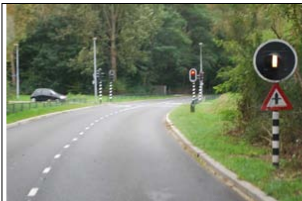
Almere: annonce de la phase verte, calée pour limiter la vitesse d'approche des bus, inférieure à 40 km/h, pour des raisons de sécurité et de confort de conduite
