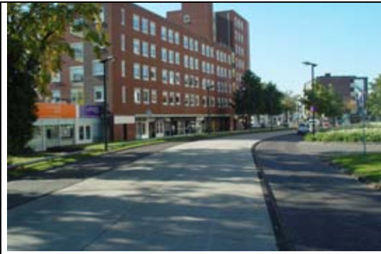
Twente: toutes les voies réservées sont entièrement en béton, pour réduire les coûts de maintenance.
