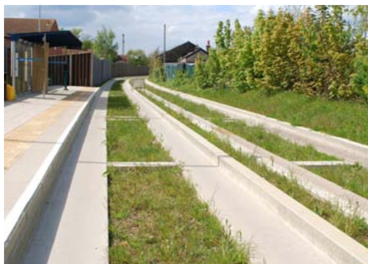
La voie guidée en béton aux abords d'une station
