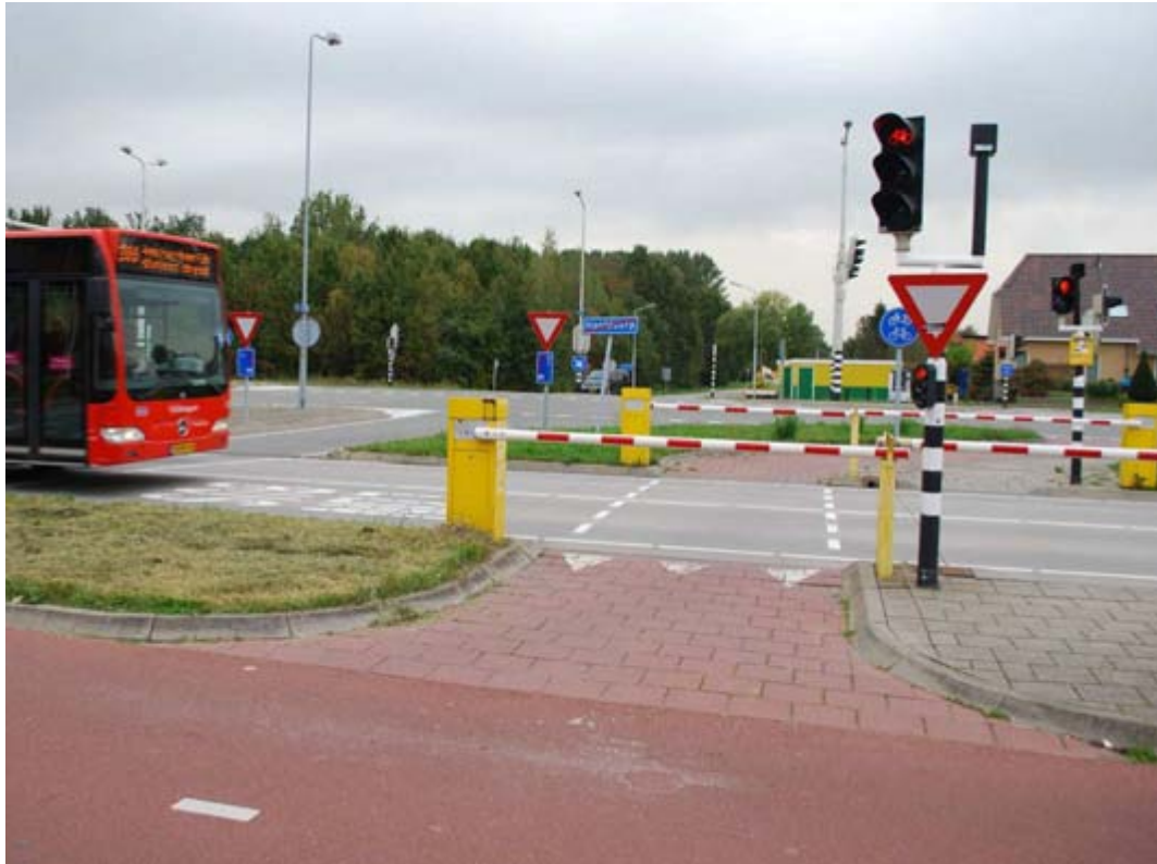
Zuidtangente : sur la section où les bus peuvent circuler à plus de 70 km/h, les passages piétons et cyclistes sont protégés par des barrières et des feux de signalisation
