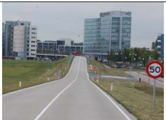
Zuidtangent: entrée d'une ligne secondaire dans le corridor, sans gestion par feux – très bonne visibilité
