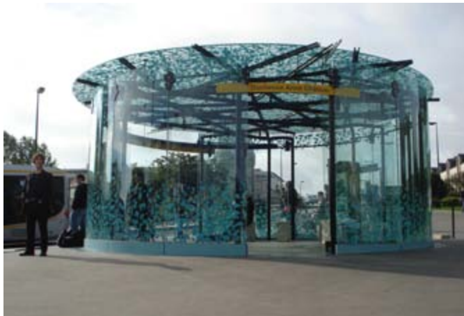
Busway: une identification spécifique pour toutes les stations – celle-ci a une forme ronde particulière, lieu d'échange avec la ligne 1 de tramway au centre ville.
