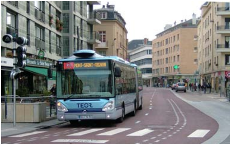
Rouen: la couleur rouge adoptée pour toutes les voies dédiées – ici au centre ville.
