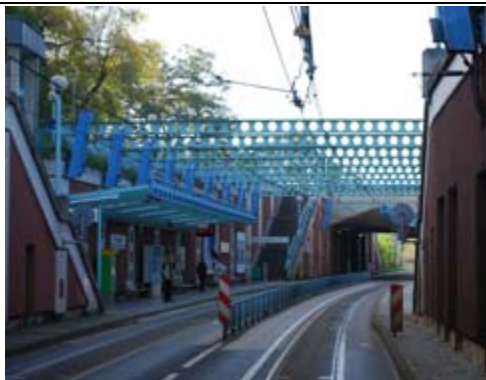
Oberhausen, une impressionnante section commune "bus and tram" type A sur 6,3 km.
