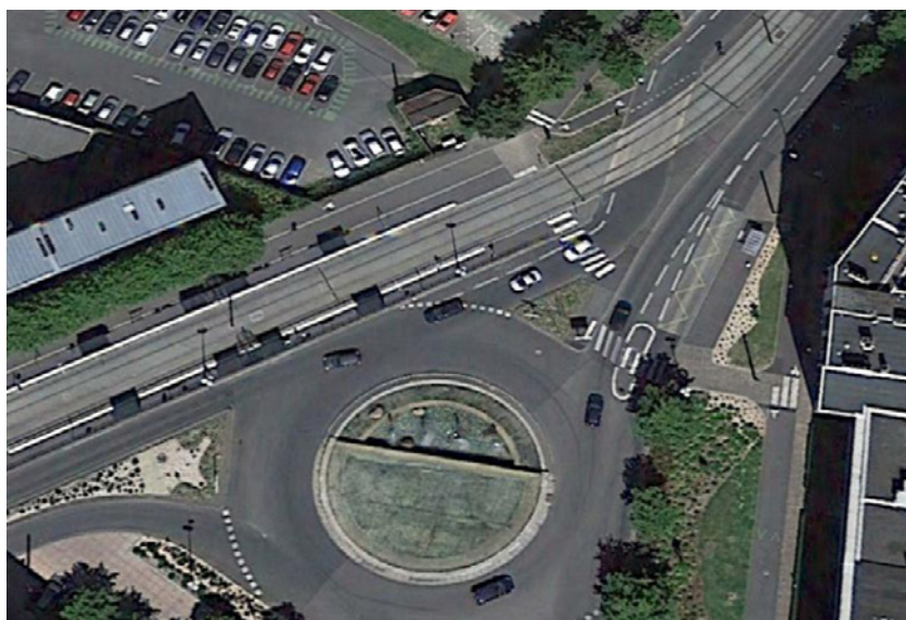
Photo 12 : matérialisation de la plate-forme en traversée d'une branche de giratoire
