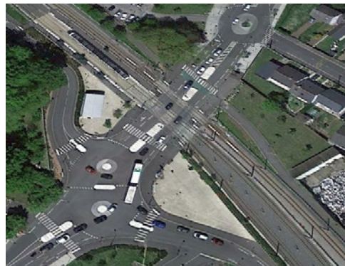
Photo 4 : tramway en site latéral au droit d'un giratoire
