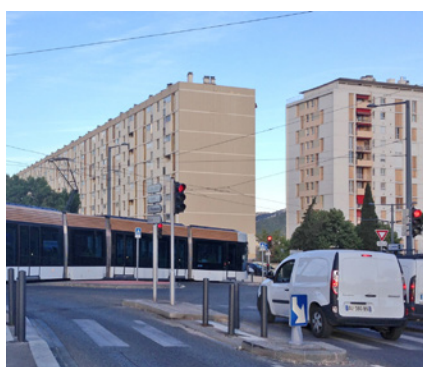
Photo 19 : la présence d'un îlot séparateur permet de répéter le signal R11j en entrée de giratoire (source STRMTG)
