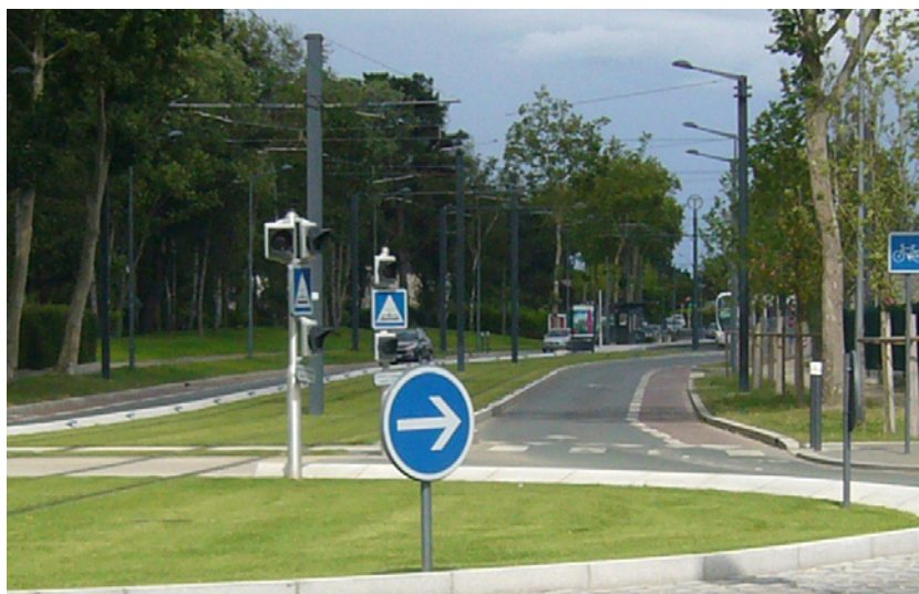
Photo 18 : La répétition des signaux R24 en barrage permet d'en optimiser la perception par tous les usagers (source : Cerema)
