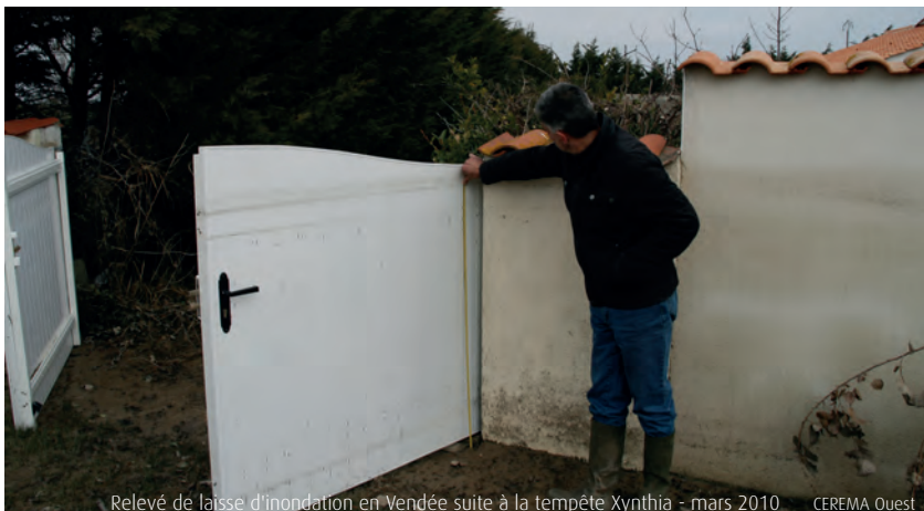
Relevé de laisse d'inondation en Vendée suite à la tempête Xynthia - mars 2010. CEREMA Ouest
