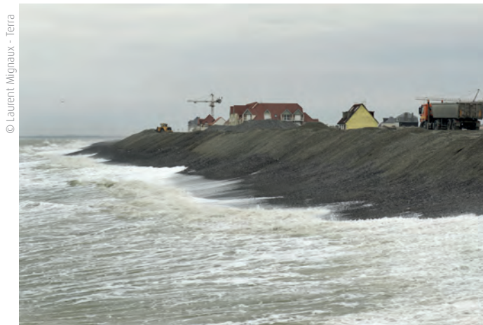
Cordon de galets de Cayeux : construction d'épis et apport artificiel de galets pour lutter contre l'érosion littorale
