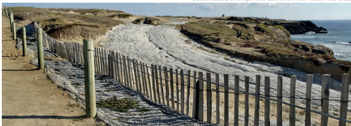
Érosion littorale, aménagements destinés à limiter l'érosion des falaises
