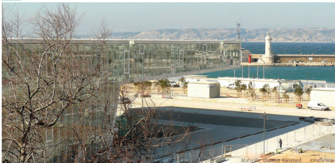
Marseille chantier Euromed ©Pierre Gras
