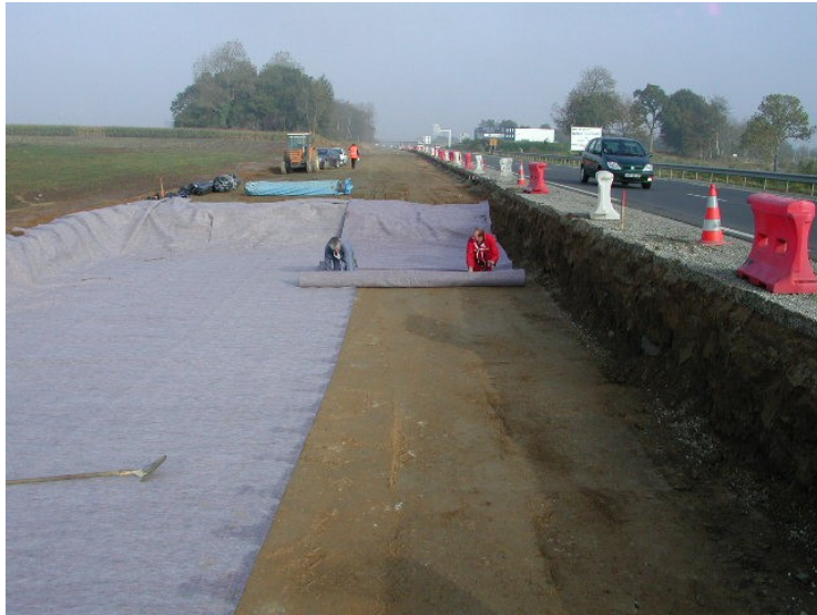
pose du géotextile sur le fond de forme
