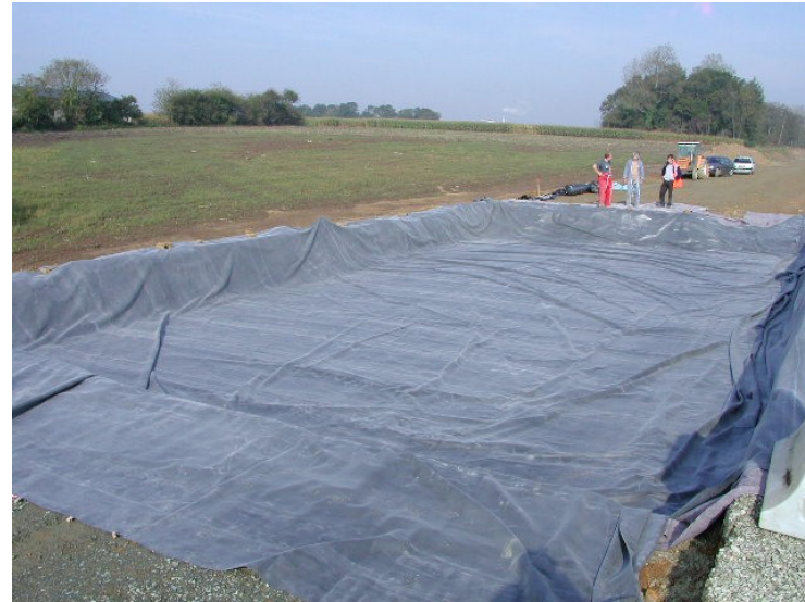
pose de la géomembrane
