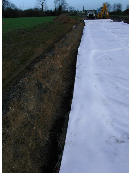
pose du géotextile
