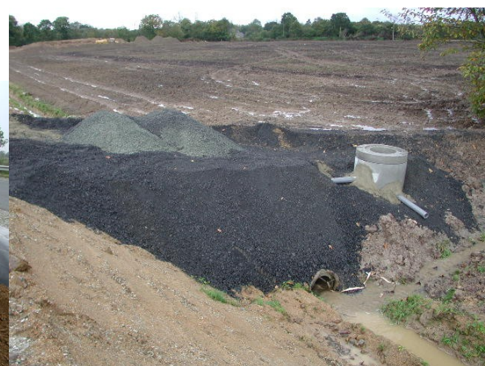
mise en œuvre du regard de collecte et du remblai d'accès
