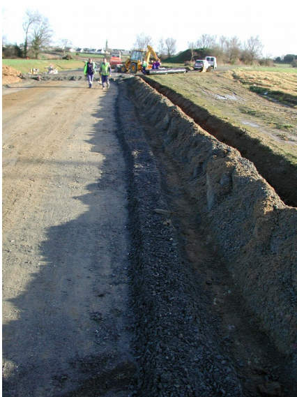
préparation du fond de forme
