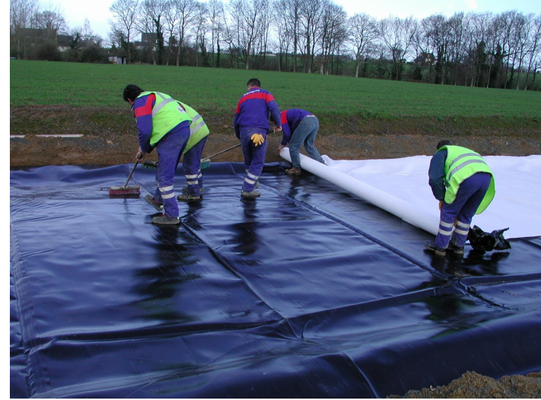
pose de la géomembrane et du géotextile de protection
