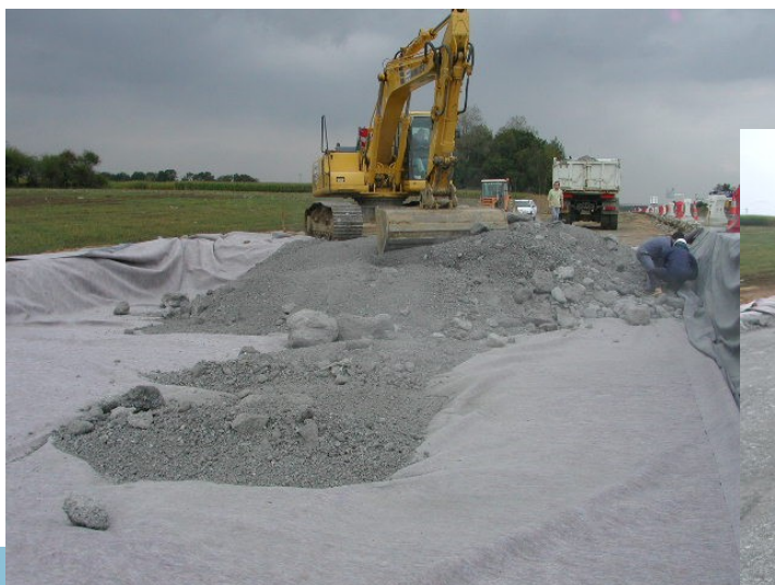
mise en œuvre des mâchefers
