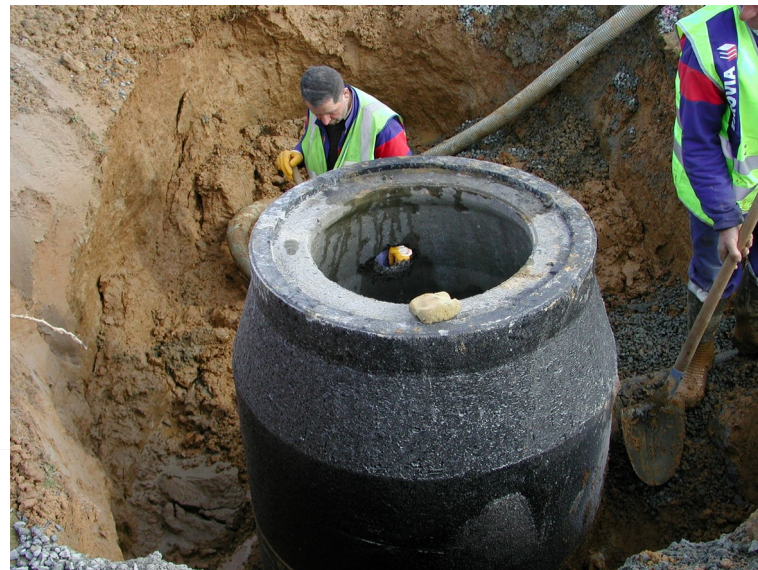
pose du regard de collecte
