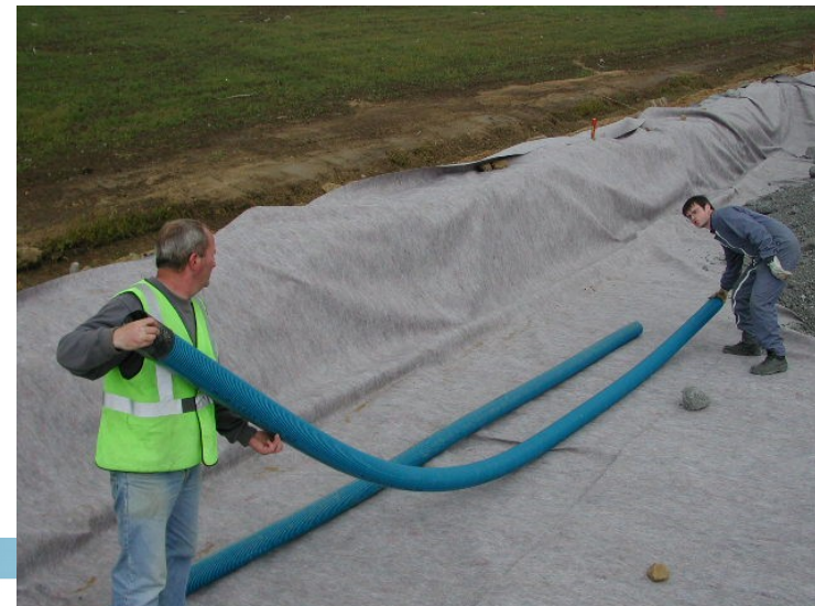
pose des drains latéraux
