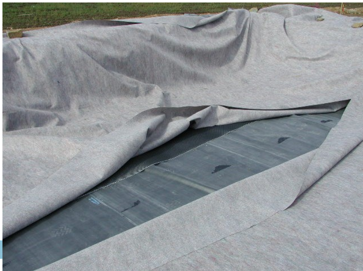
pose du géospaceur et du géotextile de protection
