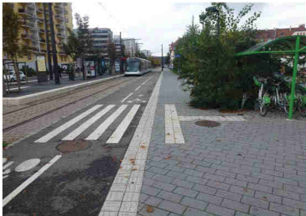
Délimitation trottoir/piste cyclable assurée par des pav'guide.
