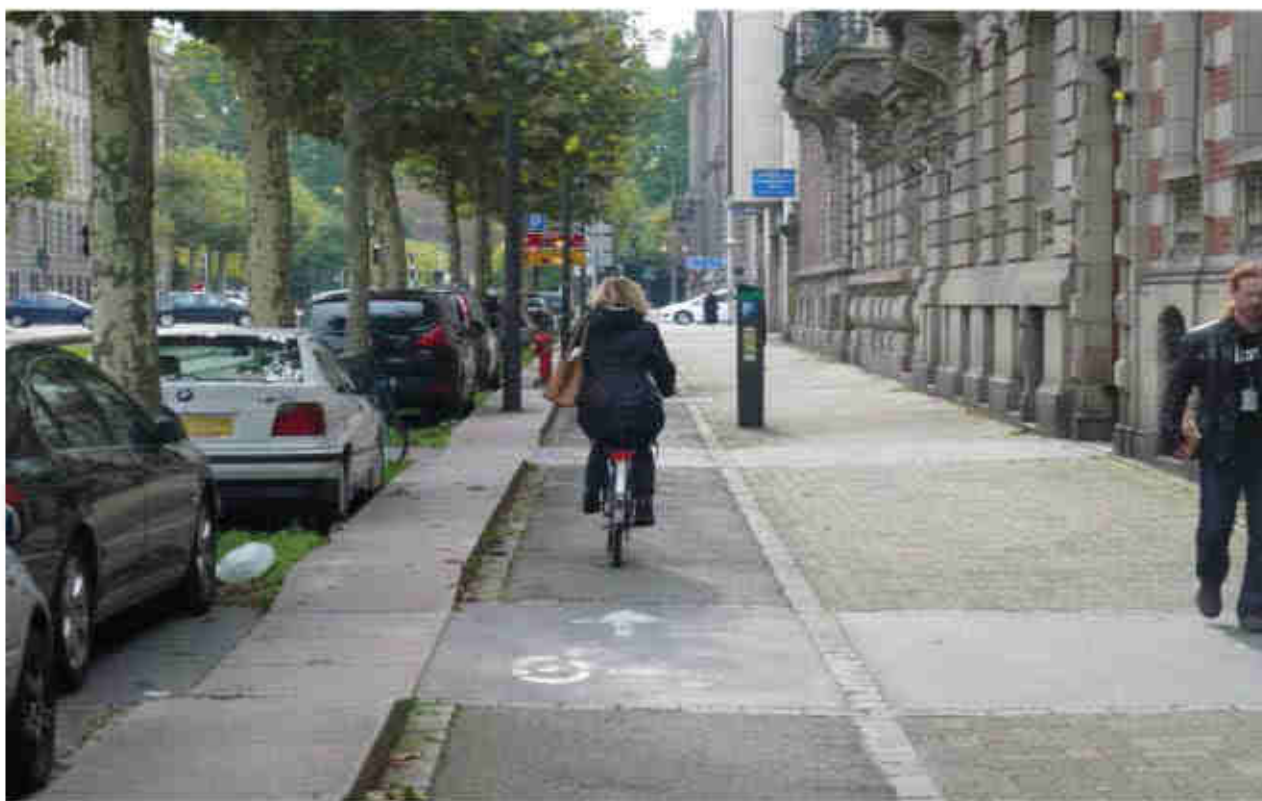
Une bordure délimite la piste cyclable et le stationnement longitudinal
