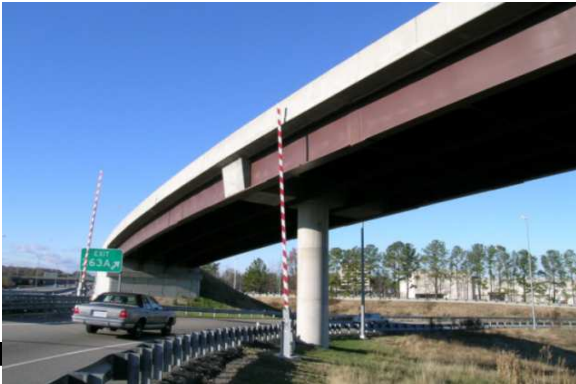
Pont intégral sur culée et piles (acier autopatinable)
