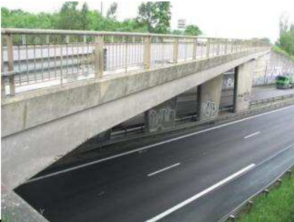
Pont D400.150 sur A31 : 2 travées de 43 m de portées biaisées
