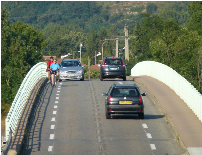
Source photo : CETE Lyon
