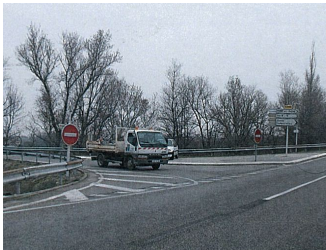
doublement des panneaux B1
