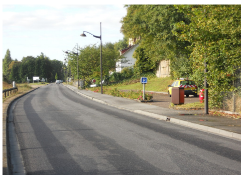
Photo 3 : vers ND Gravenchon, sortie de zone
