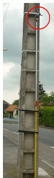
Illustration 7: Fixation de la fourche au mât d'éclairage public
