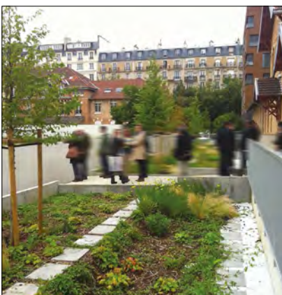
Infiltration des eaux pluviales à la parcelle dans l'ÉcoQuartier de Boucicaut à Paris.
