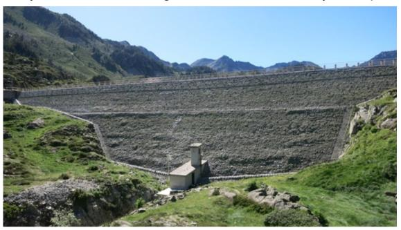
Parallèlement à la campagne de lasergrammétrie 2013 utilisée comme surface de référence, une expérimentation de photogrammétrie par drone a été menée par EDF et le SERTIT pour évaluer la faisabilité et la précision atteignable pour la réalisation du MNT du parement aval.
