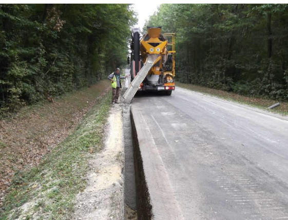
Remplissage de la tranchée par du béton
