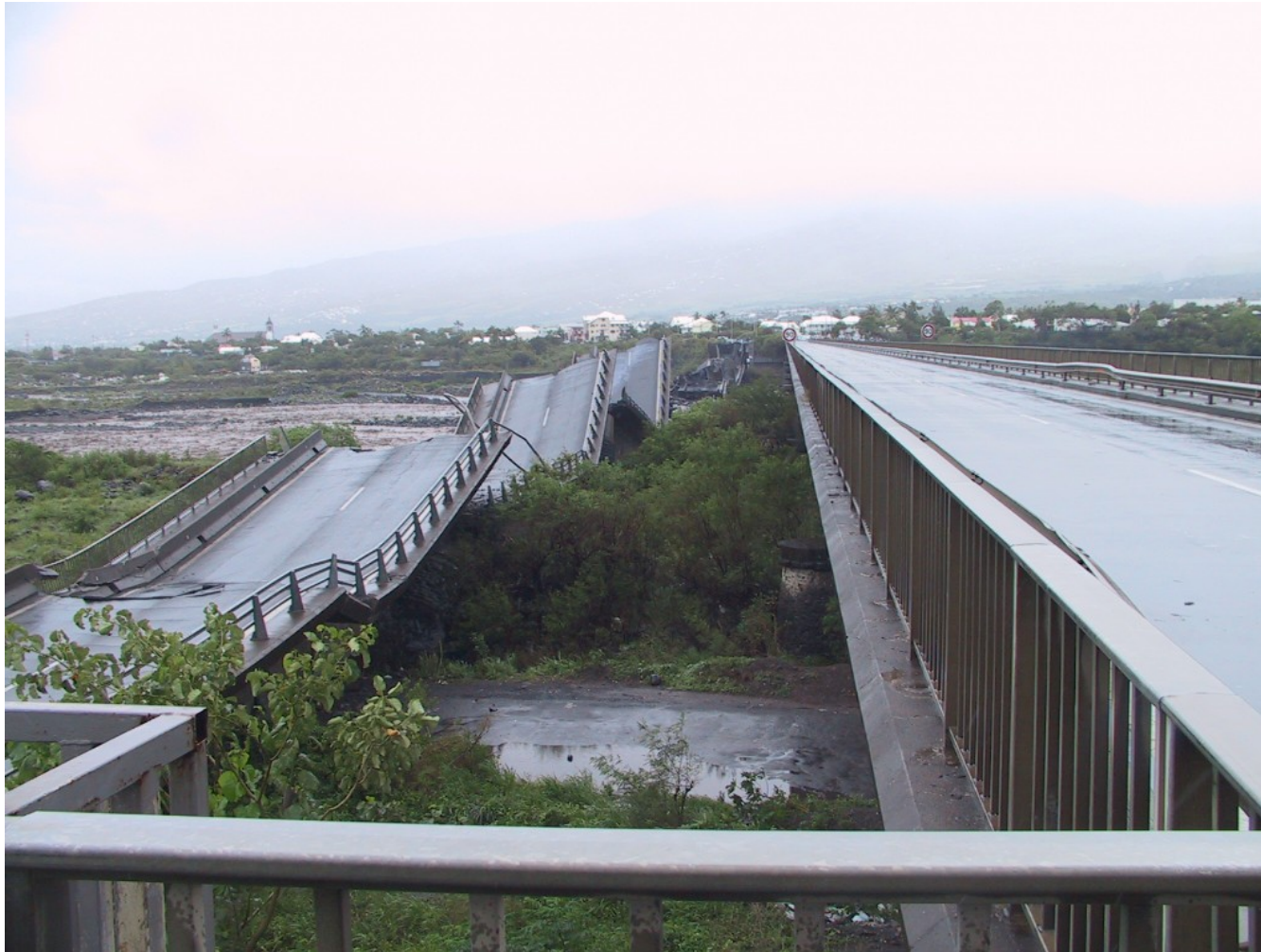
Photographie d'un pont situé sur la rivière Saint-Etienne à La Réunion qui s'est effondré le 26 février 2007 lors du passage du cyclone Gamède : ce phénomène s'est accompagné de fortes précipitations qui ont provoqué l'affouillement de certaines piles et la chute successive de plusieurs travées. Source : DDE de La Réunion
