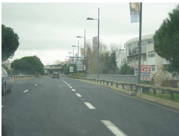
Un traitement plus urbain d'un dispositif de retenu composé d'un ensemble bordures hautes et glissières bois. (Source : Cete Méditerranée)
