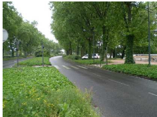
Traversée piétonne gérée par feux
