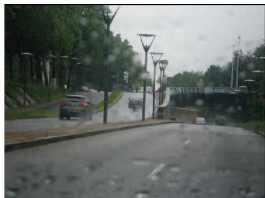
Bretelle de sortie en extrémité sud-ouest
