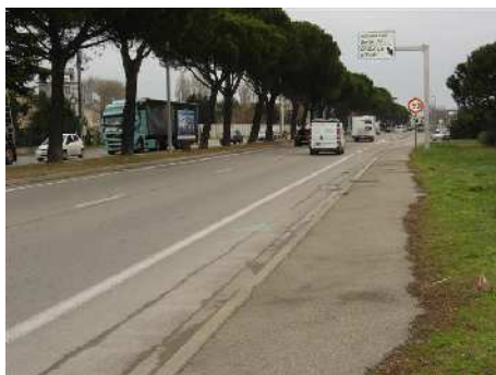
Section nord à 2x2 voies avec TPC
