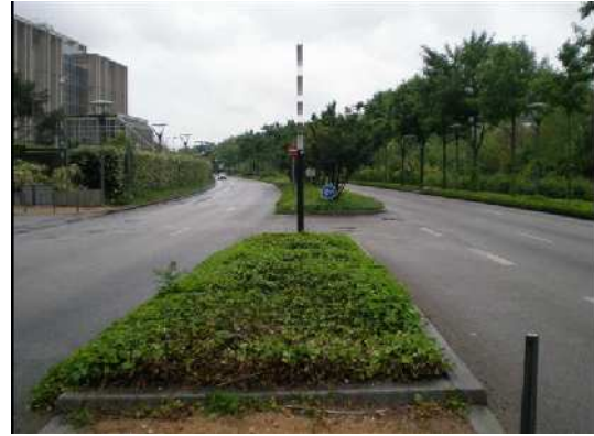
Terre plein central paysager au droit d'un carrefour
