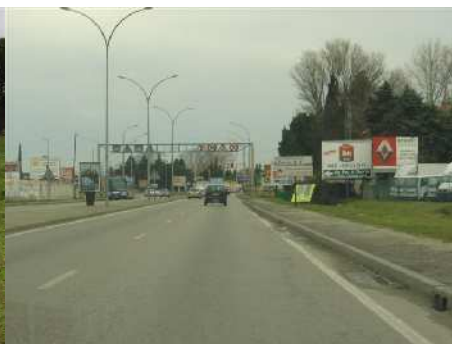
Section centrale à 2 x 2 voies avec candélabres en TPC
