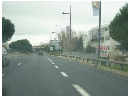
Dispositifs de retenue barrières bois lors des passages sur ouvrage et dispositif d'éclairage sur toute la section
