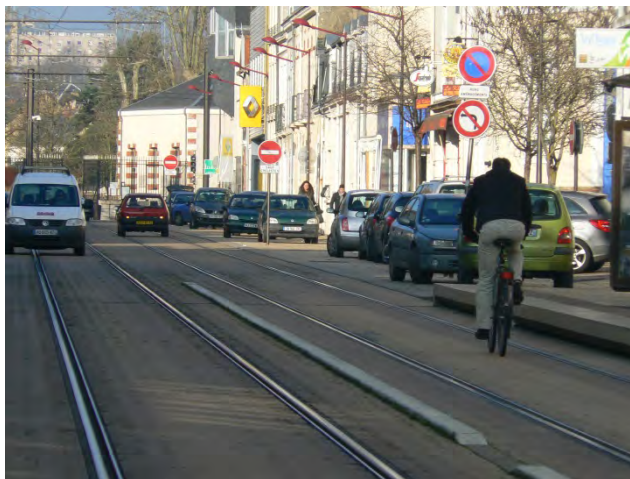
Séparateur au niveau de la station Gambetta-Muriers
