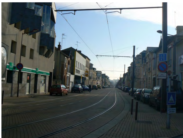
Entrée site banal depuis le boulevard Paul Chantrel
