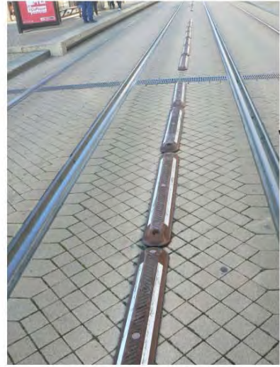
Séparateur normalement franchissable au niveau de la station
