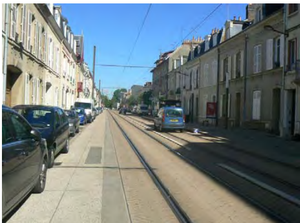
Circulation de véhicules à gauche du rail en station.
