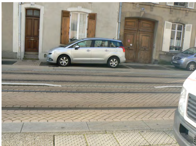
Traversée piétonne au niveau de la station Gambetta-Muriers
