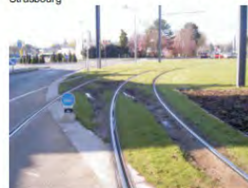
photo 39 : passage véhicule sur site propre
