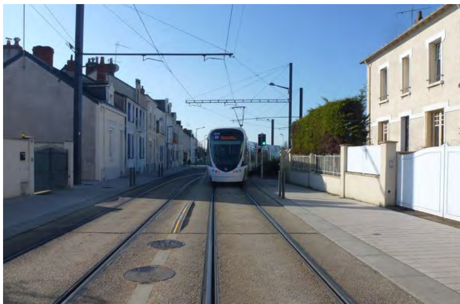
Site 3 : portail automatisé + interruption du séparateur.
