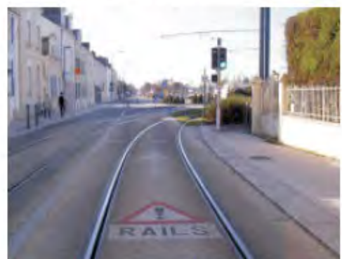
photo 38 : marquage au sol à l'attention des cyclistes devant traverser la voie tramway à la sortie du site banal
