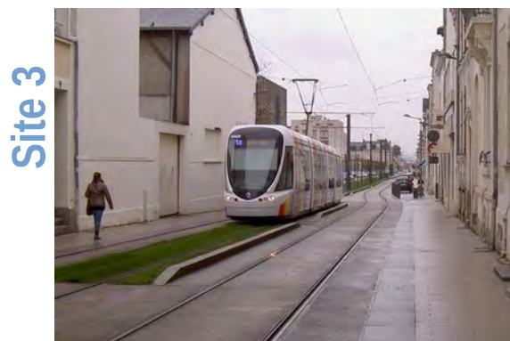
Tronçon avec 1 voie en site en site banal + 1 voie en site propre
