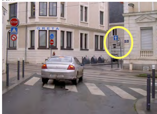
Site 3 – tronçon 1 : carrefour avec la rue Audusson. Des STOP sont implantés sur la voie transversale. Un miroir en face permet d'améliorer la visibilité sur le tram arrivant de la gauche (site banal)
