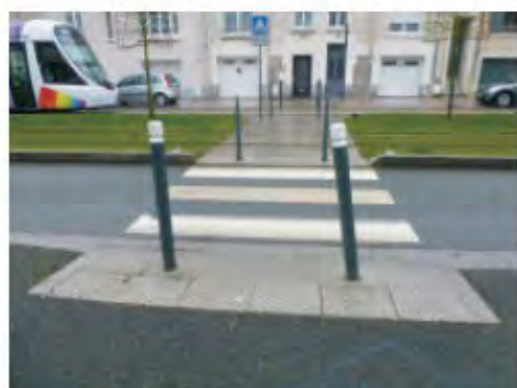
photo 14 : traversée piétonne, les BEV englobent traversée plate-forme et voirie
