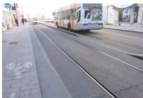
Site « Rue du Haras » : vue dans le sens inverse
