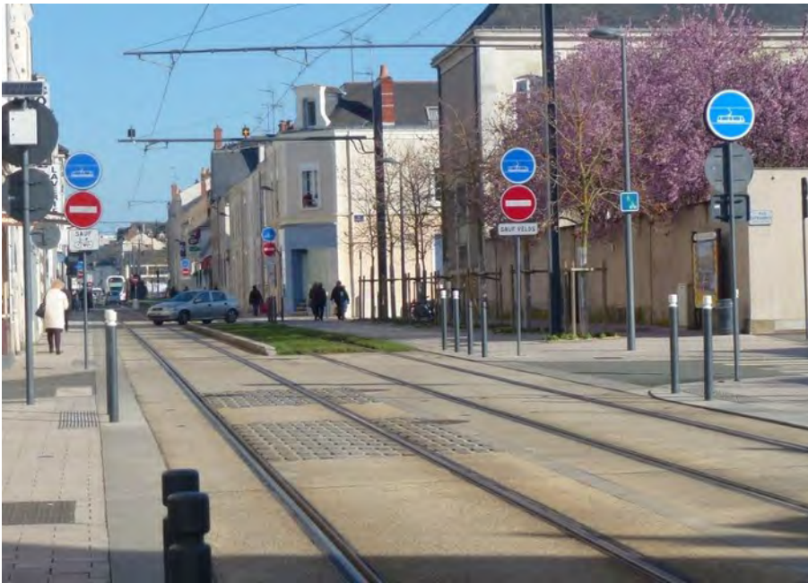
Site 3 sens Sud -->Nord : sortie du tronçon 4
