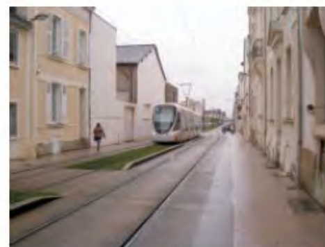
photo 7 : aménagement accès riverain
