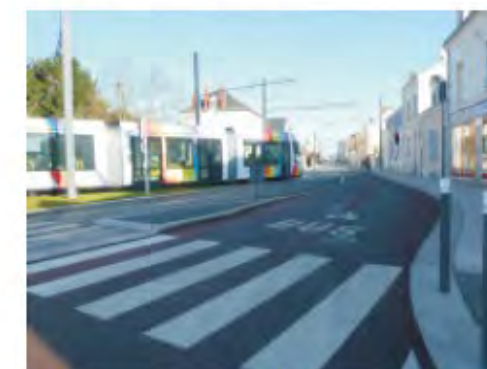
photo 40 : accès site partagé bus/tramway
