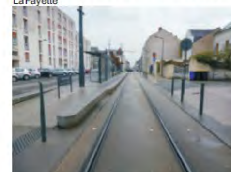
photo 12 : voie site banal au niveau de la station Lafayette
