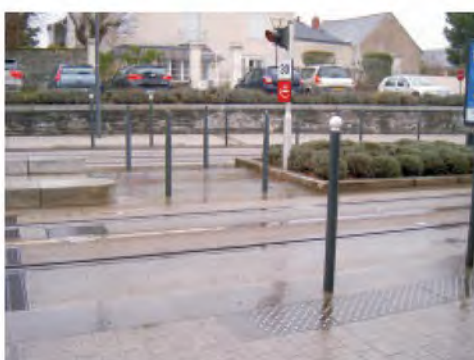
photo 5 : traversée piétonne station Bascule
