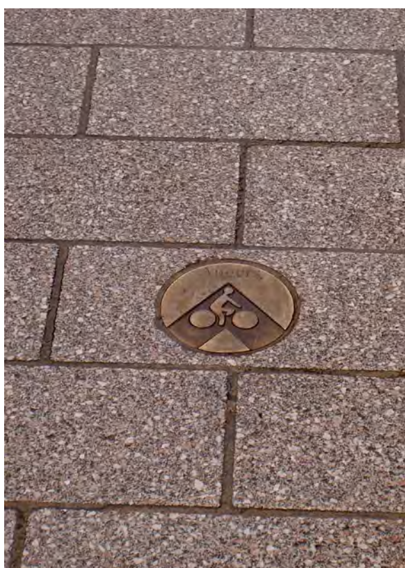
Site 3 : tronçon 3. Une section en « Voie verte » pour les vélos. Clou au sol avec pictogramme vélo.
