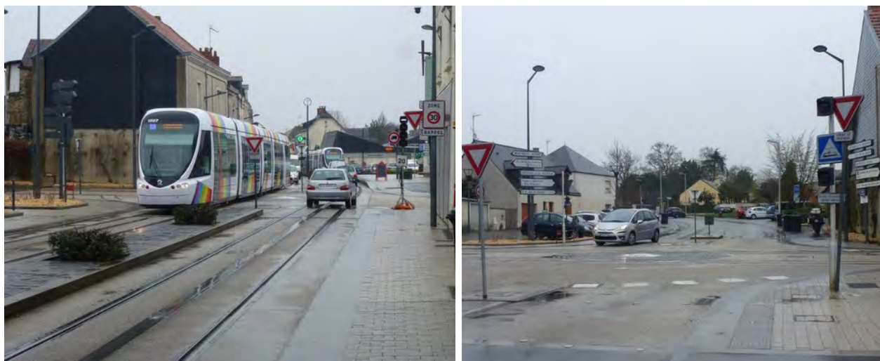
Site 1 : carrefour intermédiaire. Mini-giratoire avec feux R24 (doublés) sur les rues transversales
