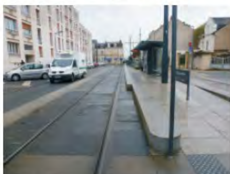
photo 13 : site propre avec séparation voirie sur station Lafayette
