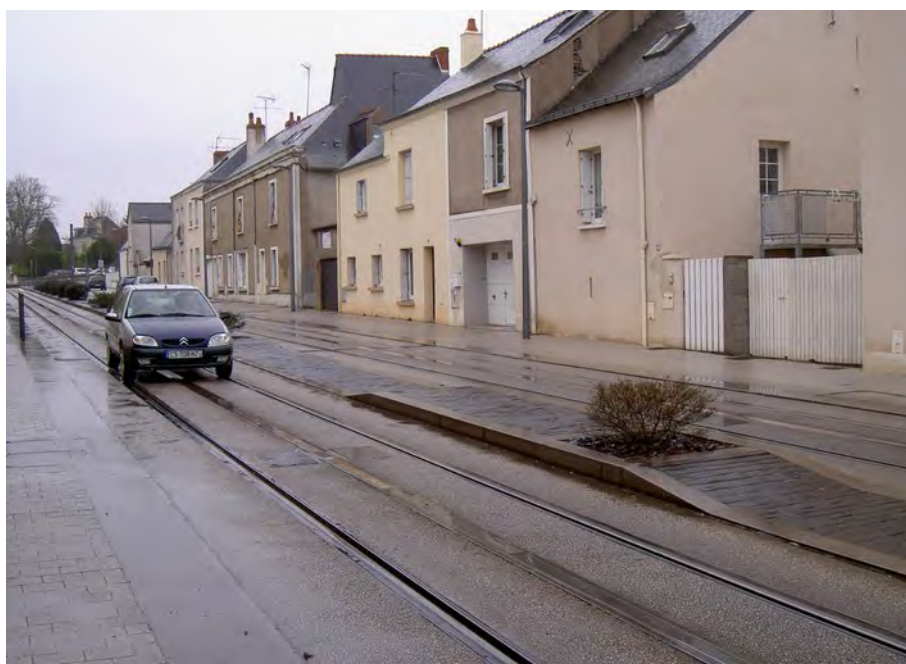
Site 1 : portail automatisé + interruption du séparateur.
