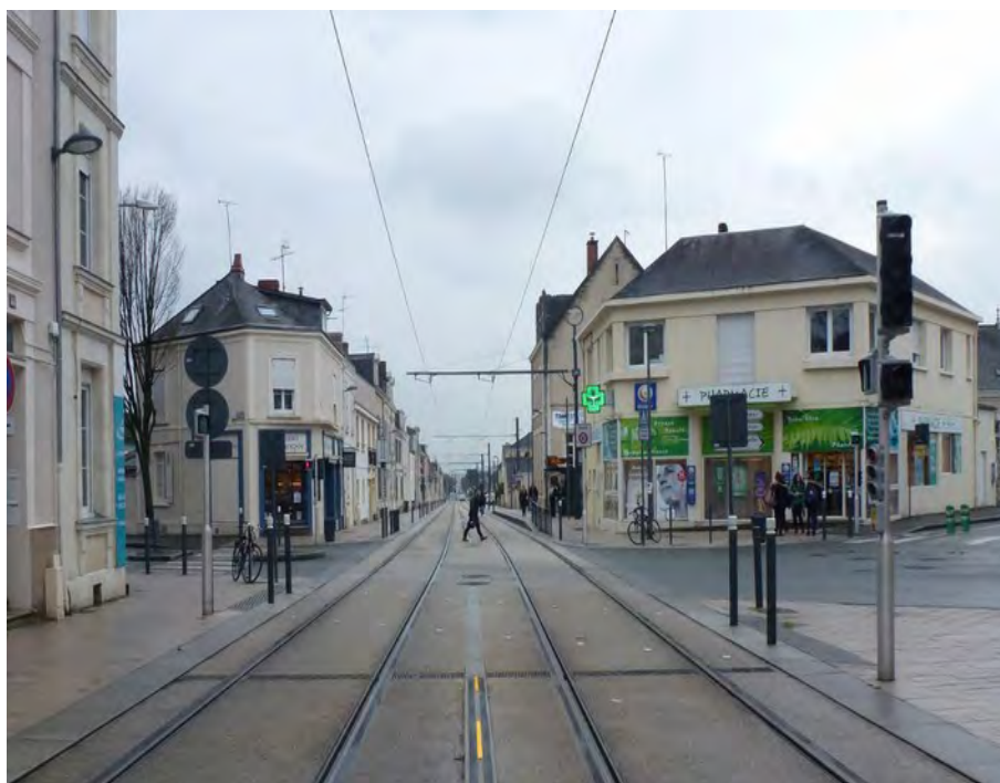
Site 3 - sens Nord --> Sud : entrée sur tronçon 5, gérée par feux R11v/R17
