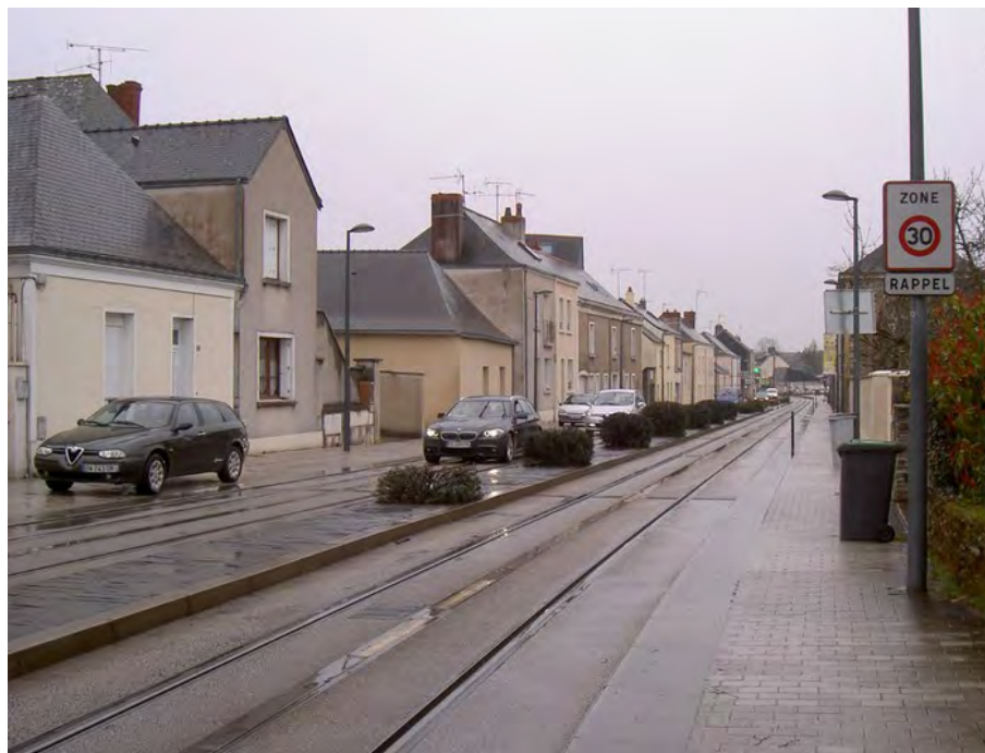
Site 1 : séparateur infranchissable implanté entre les deux voies. Largeur : 1,50m.
