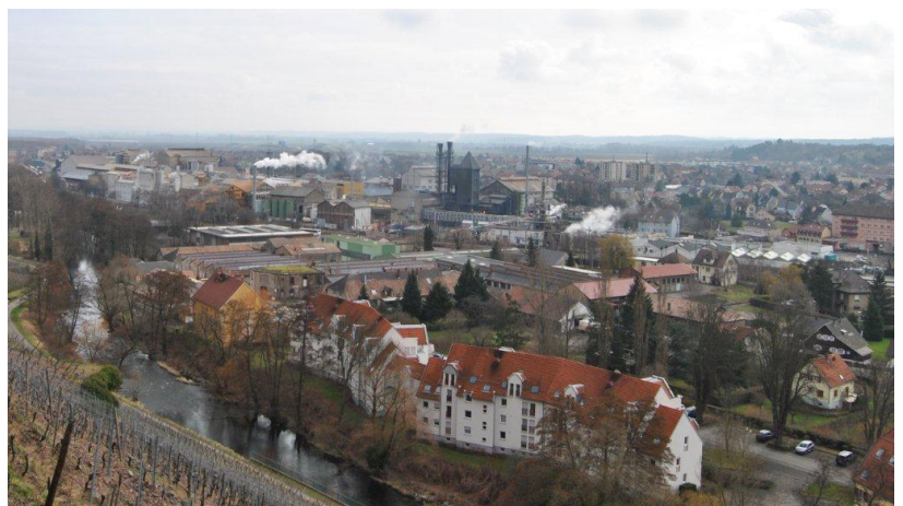
Site SEVESO de la vallée de la Thur dans le Haut-Rhin (Ville de Thann)
