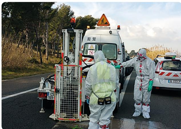
*Équipements pour la prévention du risque amiante portés lors d'une intervention de carottage sur enrobés amiantés*
