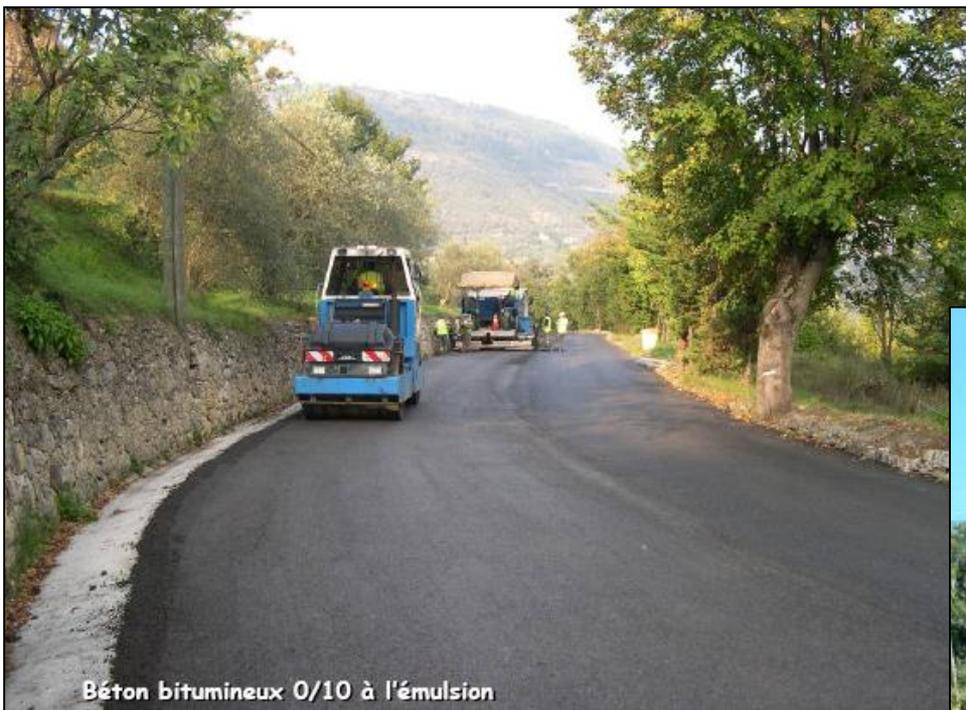
Béton bitumineux 0/10 à l'émulsion
