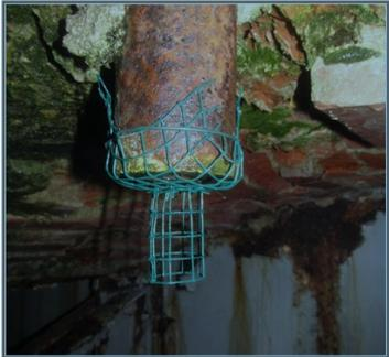
Photo 17 : Exemple de dispositif anti-retour utilisé dans le cadre de la réflexion d'un ouvrage d'art (Source : CPEPESC Franche-Comté)
