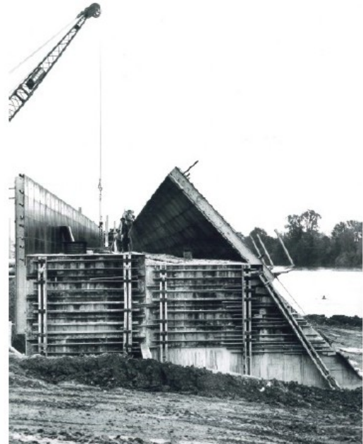
Photos de la construction de la digue en terre revêtue des Amidonniers par l'Etat dans les années 60
