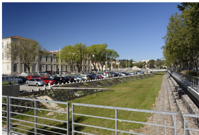
Illustration 5: Un bassin hydraulique (Source : Ville de Nîmes)
