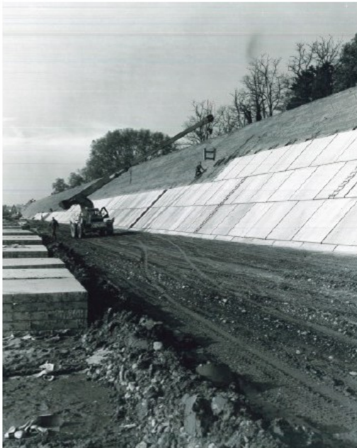
Photos de la construction de la digue en terre revêtue des Amidonniers par l'Etat dans les années 60
