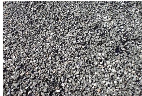
Fin de compactage
