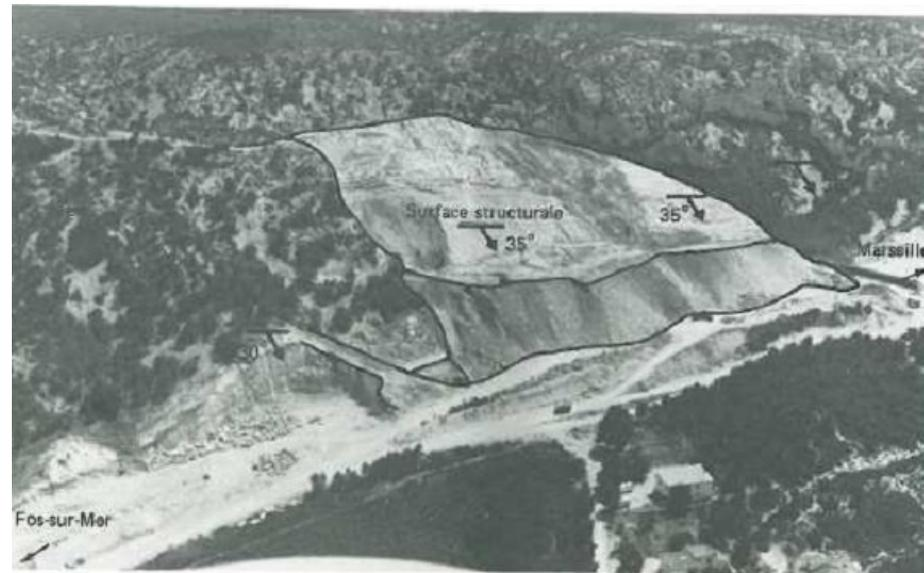
FIG. 17. — Glissement rocheux banc sur banc dans des calcaires urgoniens à pendage défavorable de 35°. La photographie a été prise pendant la purge du glissement, celle-ci se faisant du haut vers le bas suivant une surface structurale qui apparaît au sommet du déblai.
