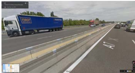
Expérimentation A7 ASF LIER/TRANSPOLIS H2 et H4b, W=3,20m pour 1m d'espacement
