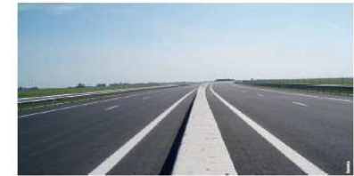
Chaussée autoroutière neuve avant mise en service Legend 08
